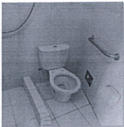
Imagen N° 01: Inodoro en mal estado, filtra agua por la parte baja.
