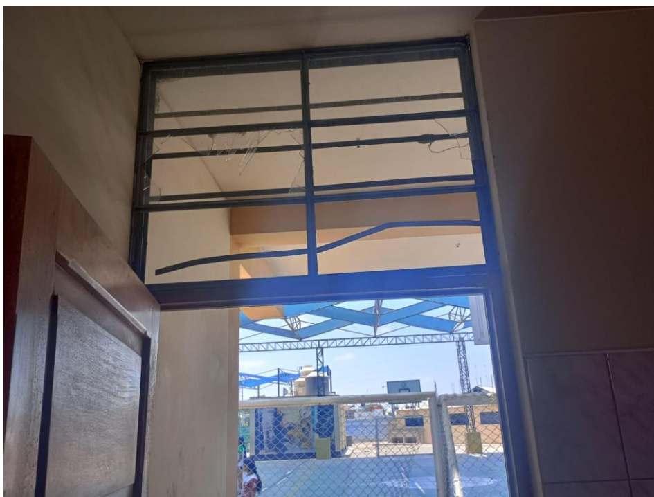
FOTO N° 06: Rejas de seguridad en puertas en mal estado.
