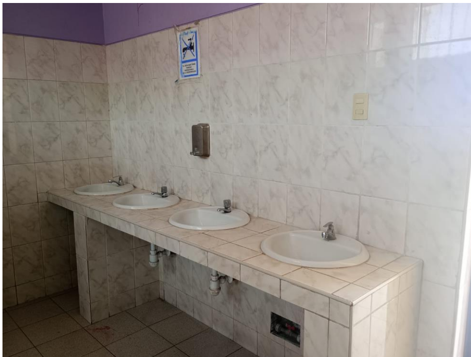
FOTO N° 05: Llave de lavatorios y dispensador en mal estado.
