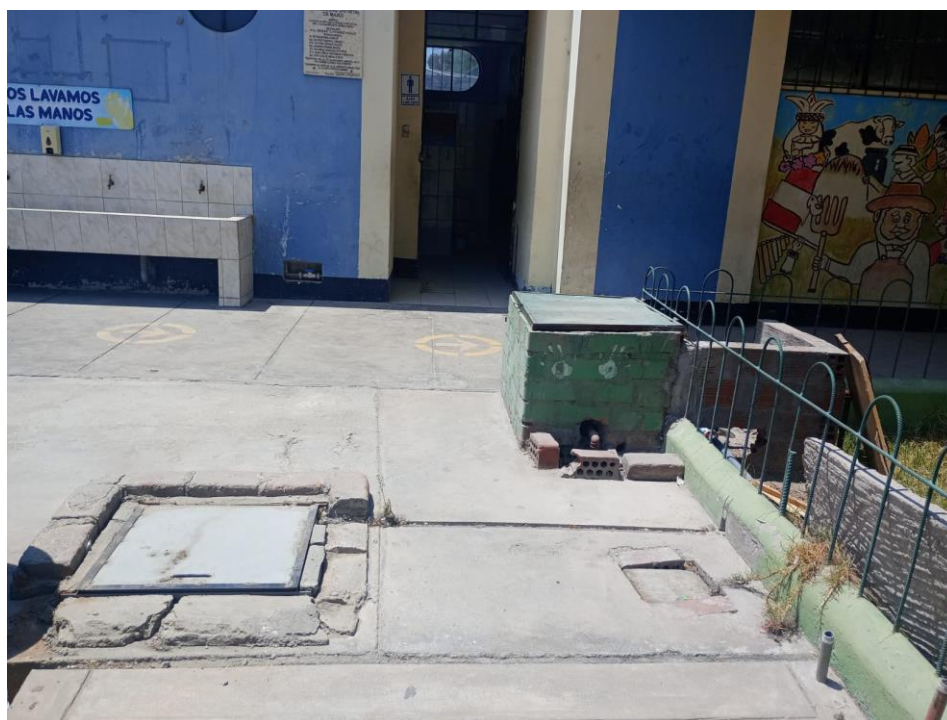
FOTO N° 10: Muro de caja de bomba de impulsión en mal estado, tapas metálicas en mal estado.
