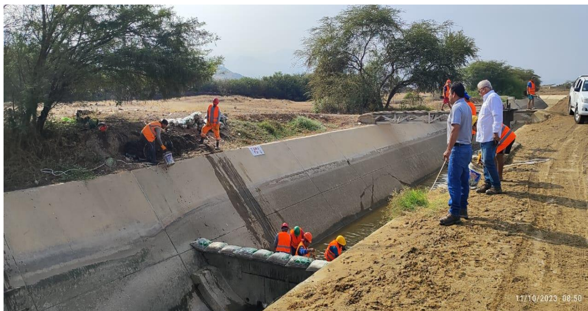
Figura N° 16: Mantenimiento en Canal Derivador Talambo Zaña.
