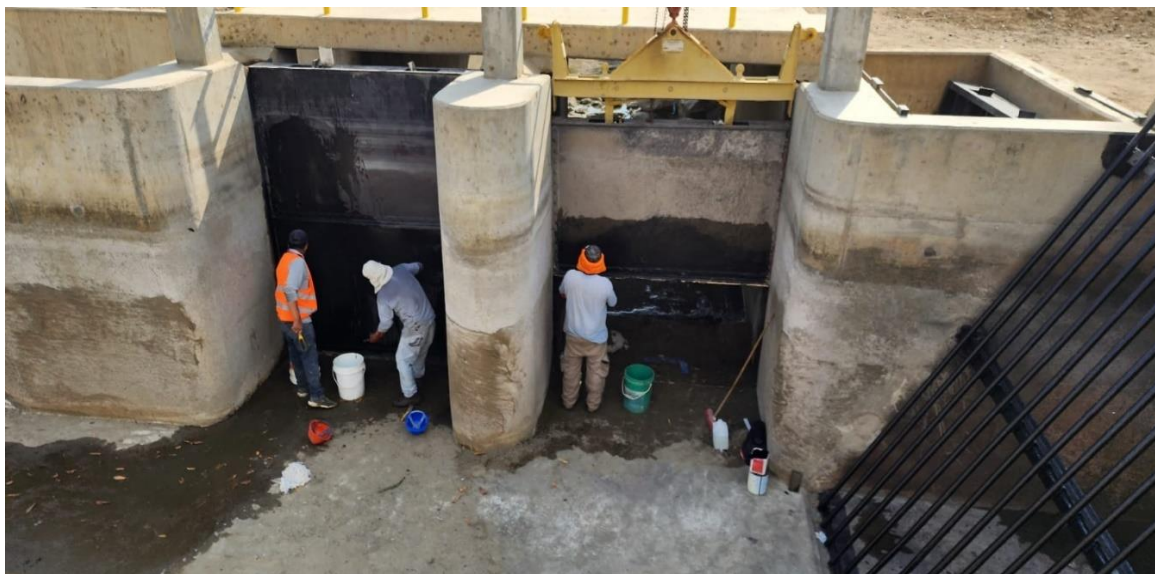
Figura N° 17: Mantenimiento de Compuertas en Sifón Chamán.
