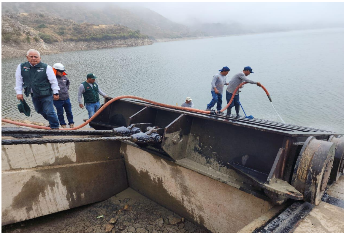
Figura N° 09: Mantenimiento de Compuerta Vagón del Túnel en Casa de Máquinas.
