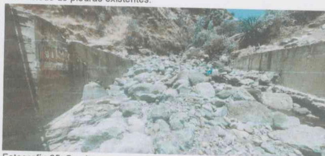
Fotografía 05: Se observa que requiere descolmatación aguas arriba
