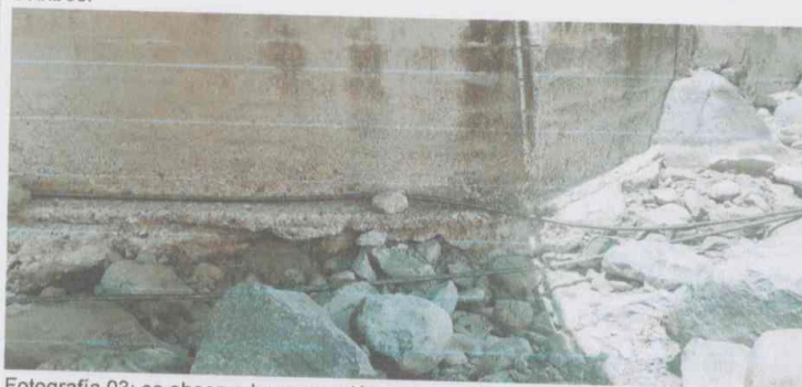
Fotografía 03: se observa la socavación en los estribos
