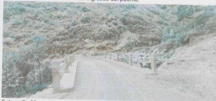
Fotografía 02: se observa que no cuenta con losa de aproximación.
