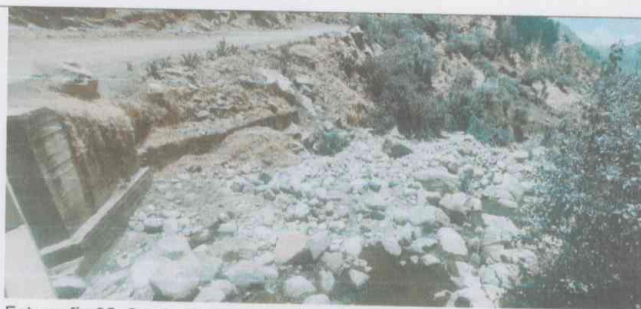
Fotografía 05: Se observa que requiere descolmatación aguas abajo
