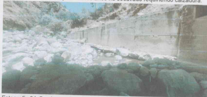
Fotografía 04: Se observa la socavación de los muros de encausamiento el mismo requiere calzadura.
