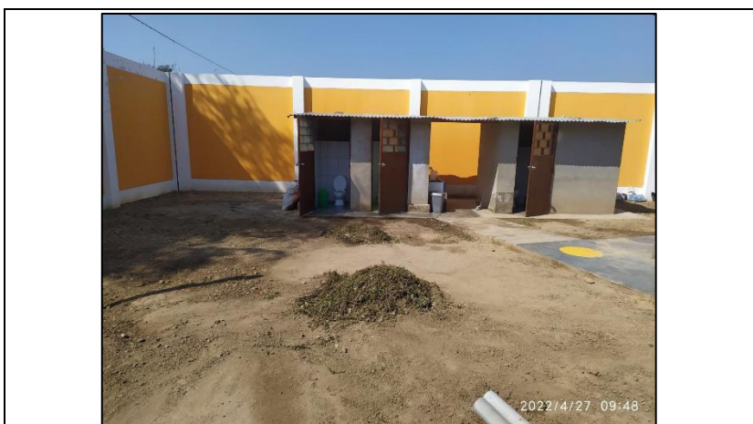
FOTO N° 08: Vista de los SS.HH. de material precario (adobe), se recomienda demoler
