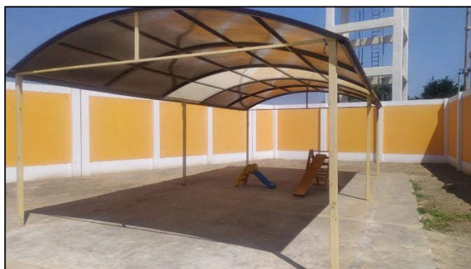
FOTO N° 09: Vista de la losa de recreación, se aprecia que fue construido sin dirección técnica, sin control de calidad de los materiales y sin dosificación de mezcla, ni con planos aprobados por la autoridad competente, se encuentran con regular estado de conservación
