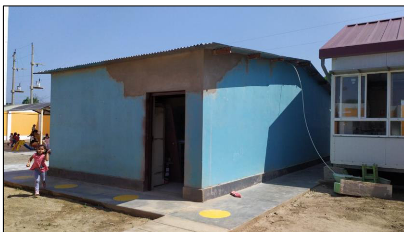
FOTO N° 07: Vista Exterior de la Cocina-Almacén de la I.E.384 construido con material precario (adobe).
