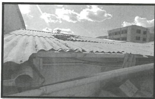
Superficie de techo y canaleta de aguas pluviales con materia orgánica.
