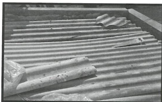
Superficie de techo con moho.
