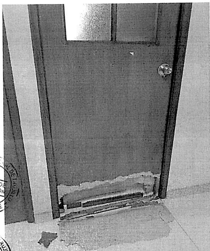
Puertas contra placadas rotas, afectadas por las lluvias
