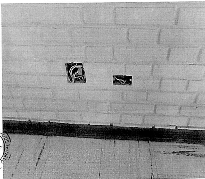
Accesorios eléctricos, rotos, (tomacorrientes)
