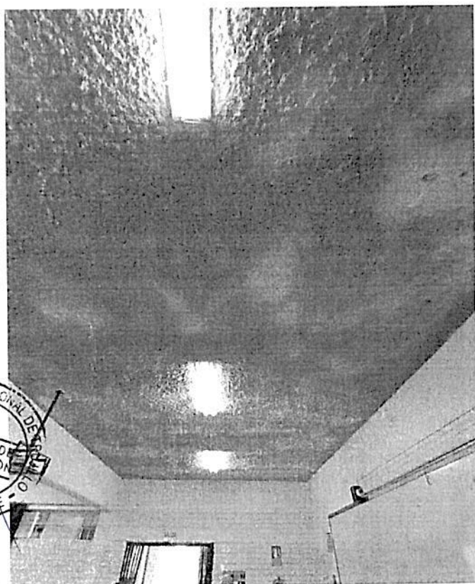
Cielorrasos, antiguos, (material asbesto),
