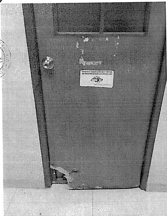
Puertas contra placadas rotas, afectadas por las lluvias
