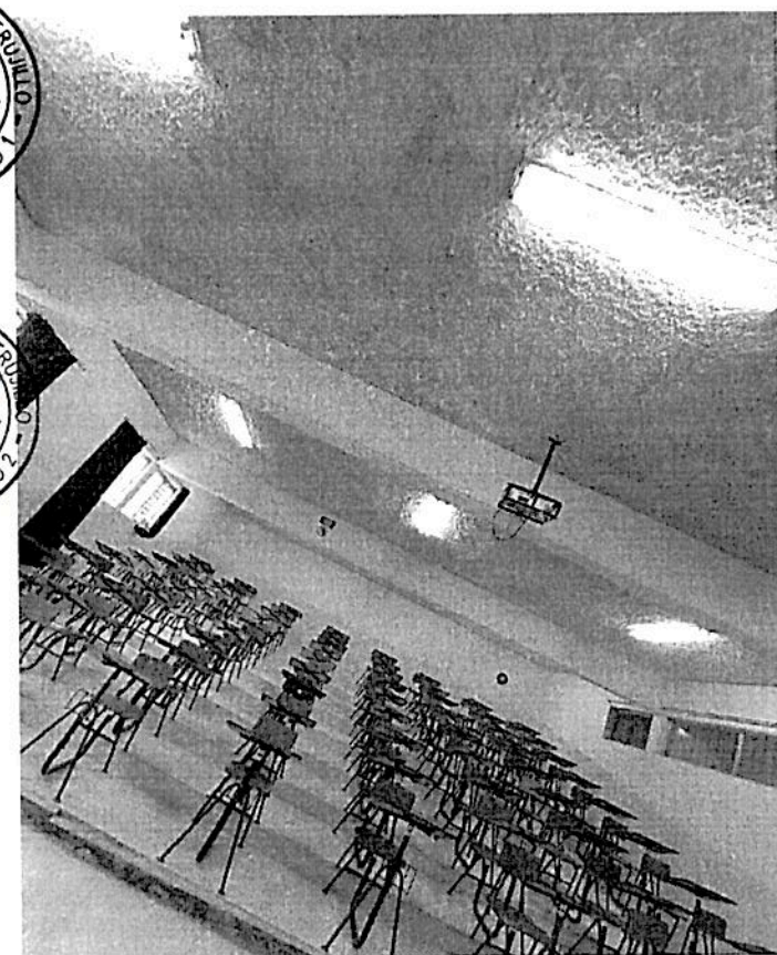
Cielorrasos, antiguos, (material asbesto),
