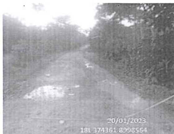
Foto 244: El tramo evaluado desde la prog. 1+985 a la prog. 1+999, presenta daños en la calzada de tipo Baches, encontrándose 9, de nivel de gravedad: 2.
