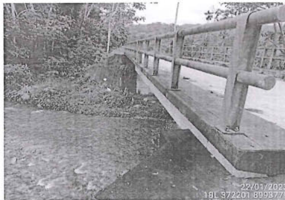
Foto 134: Puente, con Tablero de rodadura de Concreto en Buena Condición Funcional, Prog. 2+050
