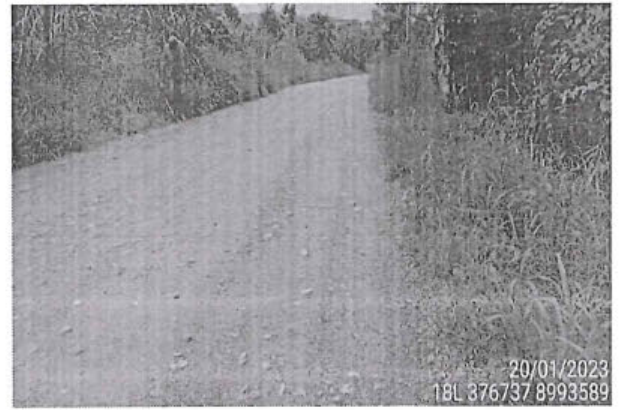
Foto 184: El tramo evaluado desde la prog. 42+500 a la prog. 42+690, presenta daños en la calzada de tipo Deformación, de nivel de gravedad: 3 alcanzando 1.40 m. de ancho de deterioro.
