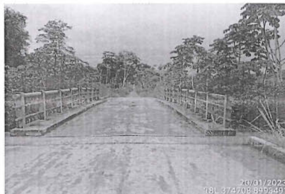
Foto 50: Puente, con Tablero de rodadura de Concreto en Buena Condición Funcional, Prog. 42+073
