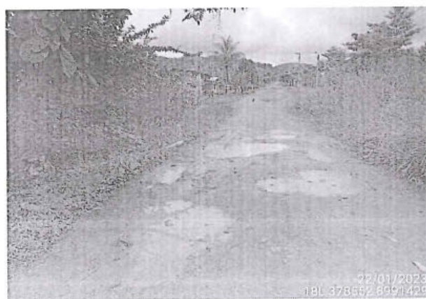
Foto 211: El tramo evaluado desde la prog. 0+997 a la prog. 1+000, presenta daños en la calzada de tipo Baches, encontrándose 11, de nivel de gravedad: 3.
