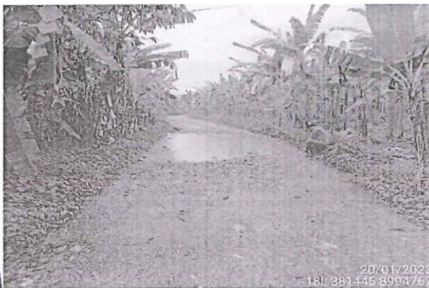
Foto 161: El tramo evaluado desde la prog. 03+625 a la prog. 03+630, presenta daños en la calzada de tipo Cruce de Agua, afectando todo el ancho de la vía (3.90 m.)
