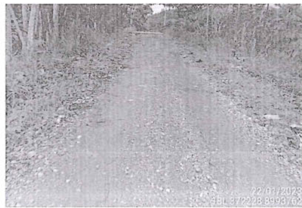
Foto 242: El tramo evaluado desde la prog. 1+560 a la prog. 1+790, presenta daños en la calzada de tipo Deformacion, de nivel de gravedad: 3 alcanzando 1.10 m. de ancho de deterioro.
