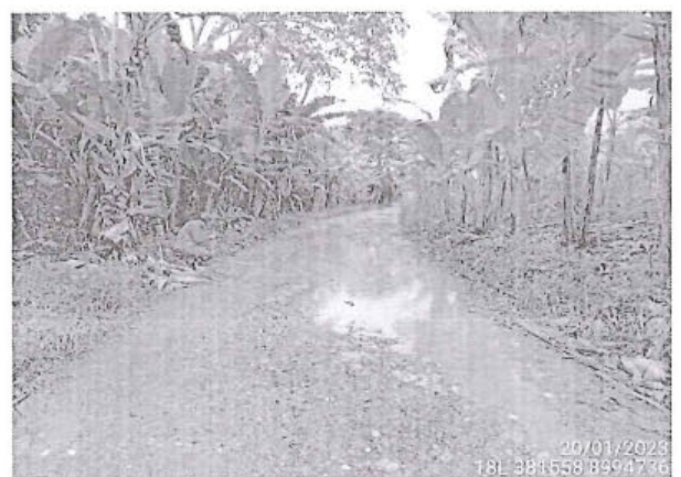
Foto 158: El tramo evaluado desde la prog. 02+990 a la prog. 03+000, presenta daños en la calzada de tipo Cruce de Agua, afectando todo el ancho de la vía (4.50 m.)
