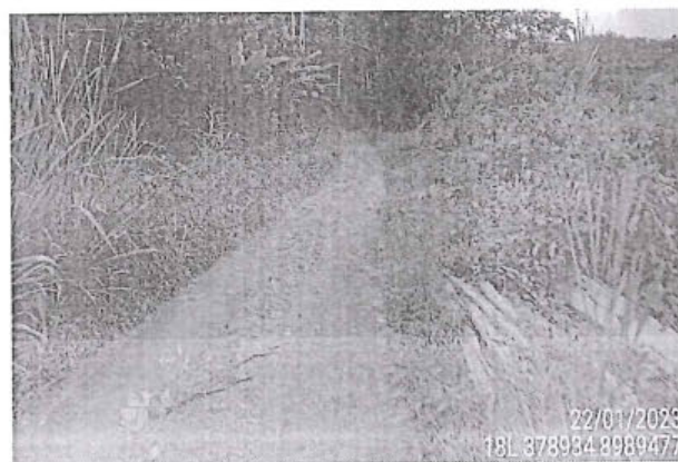
Foto 223: El tramo evaluado desde la prog. 02+959 a la prog. 02+960, presenta daños en la calzada de tipo Baches, encontrándose 1, de nivel de gravedad: 3.
