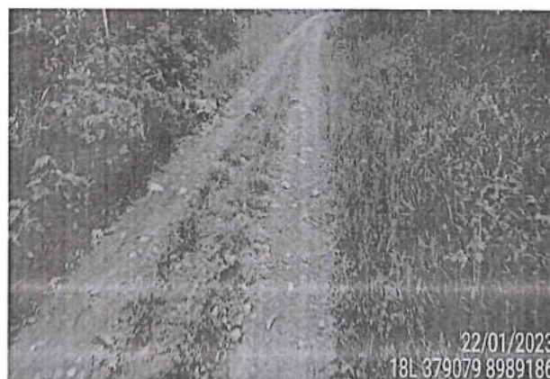
Foto 226: El tramo evaluado desde la prog. 3+410 a la prog. 3+500, presenta daños en la calzada de tipo Deformación, de nivel de gravedad: 3 alcanzando 0.70 m. de ancho de deterioro.
