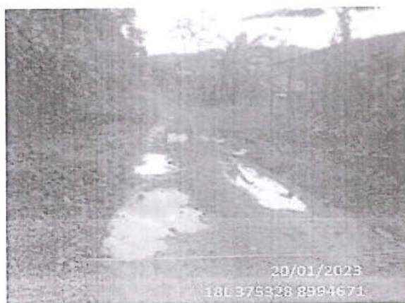
Foto 235: El tramo evaluado desde la prog. 05+714 a la prog. 05+720, presenta daños en la calzada de tipo Baches, encontrándose 4, de nivel de gravedad: 2.
