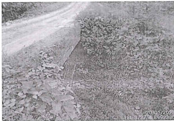
Foto 71: Alcantarilla, en regular condicion. Prog. 45+453
