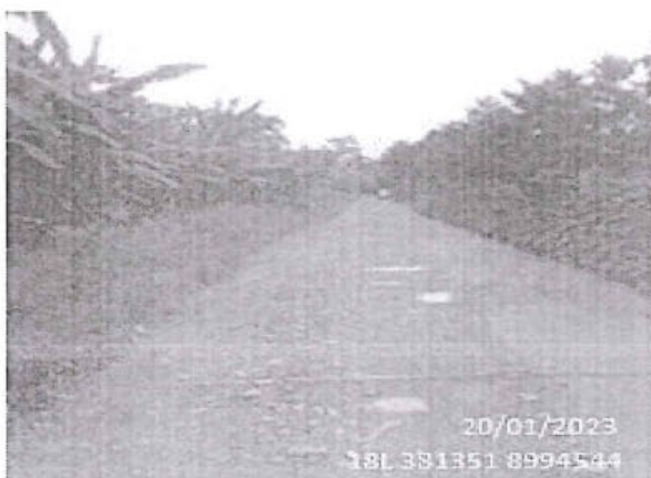
Foto 163: El tramo evaluado desde la prog. 03+993 a la prog. 04+000, presenta daños en la calzada de tipo Baches, encontrándose 13, de nivel de gravedad: 2.
