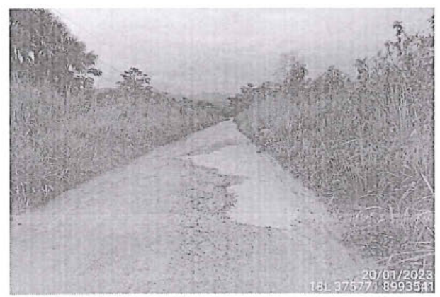
Foto 188: El tramo evaluado desde la prog. 43+598 a la prog. 43+600, presenta daños en la calzada de tipo Baches, encontrándose 6, de nivel de gravedad: 3.
