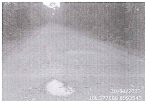
Foto 176: El tramo evaluado desde la prog. 39+994 a la prog. 40+000, presenta daños en la calzada de tipo Baches, encontrándose 60, de nivel de gravedad: 2.
