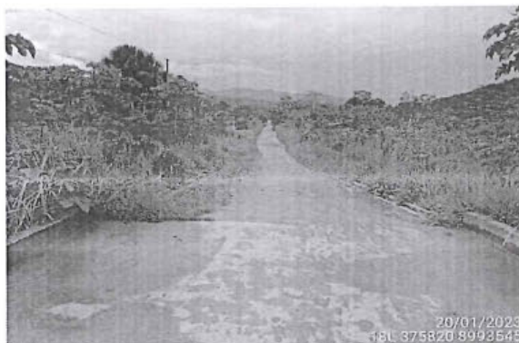
Foto 37: Superficie de rodadura de afirmado y estado de transitabilidad bueno, prog. 39+500
