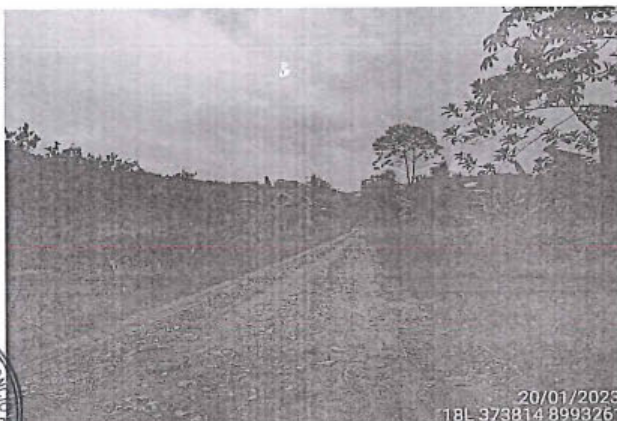
Foto 203: El tramo evaluado desde la prog. 47+000 a la prog. 47+490, presenta daños en la calzada de tipo Erosión, de nivel de gravedad: 3 alcanzando 2.70 m. de ancho de deterioro.
