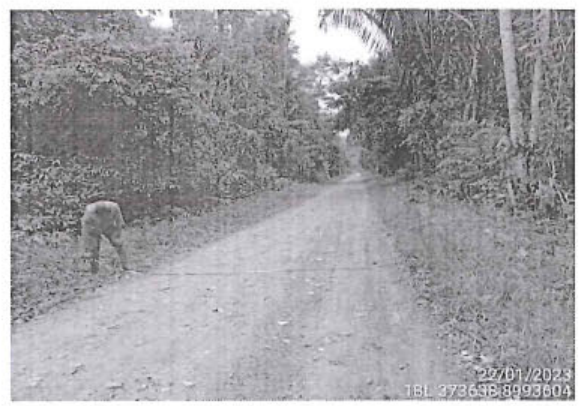
Foto 126: Superficie de rodadura de afirmado y estado de transitabilidad bueno, prog. 0+500
