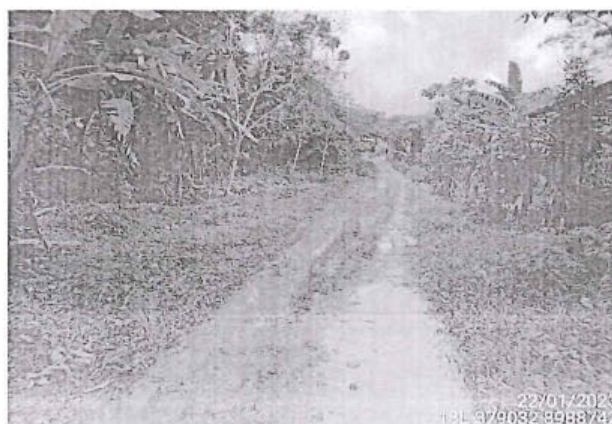
Foto 229: El tramo evaluado desde la prog. 4+050 a la prog. 4+060, presenta daños en la calzada de tipo Cruce de Agua, afectando todo el ancho de la vía (2.70 m.)
