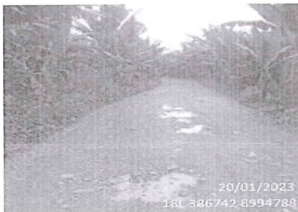
foto 157: El tramo evaluado desde la prog. 02+982 a la prog. 02+990, presenta daños en la calzada de tipo Baches, encontrándose 13, de nivel de gravedad: 2.
