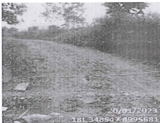
Foto 201: El tramo evaluado desde la prog. 46+500 a la prog. 46+860, presenta daños en la calzada de tipo Erosión, de nivel de gravedad: 3 alcanzando 1.60 m. de ancho de deterioro.
