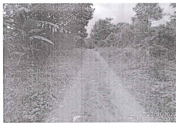
Foto 252: El tramo evaluado desde la prog. 4+000 a la prog. 4+500, presenta daños en la calzada de tipo Erosión, de nivel de gravedad: 3 alcanzando 0.80 m. de ancho de deterioro.
