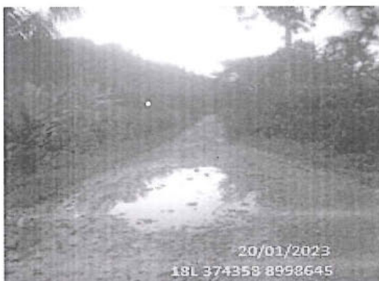
Foto 243: El tramo evaluado desde la prog. 1+847 a la prog. 1+960, presenta daños en la calzada de tipo Baches, encontrándose 17, de nivel de gravedad: 2.
