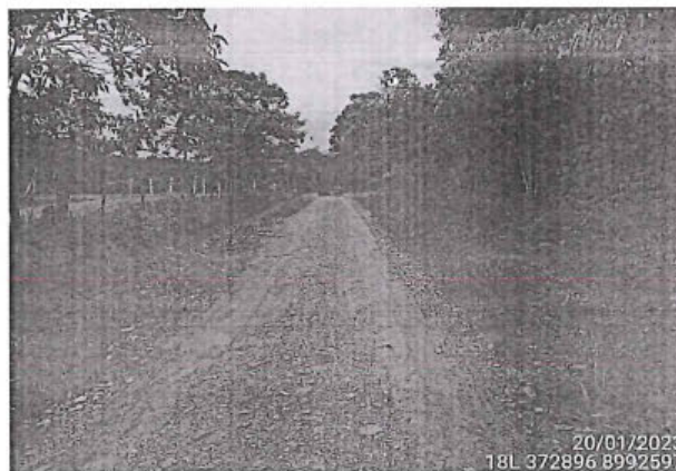
Foto 204: El tramo evaluado desde la prog. 47+500 a la prog. 47+760, presenta daños en la calzada de tipo Deformacion, de nivel de gravedad: 3 alcanzando 2.00 m. de ancho de deterioro.
