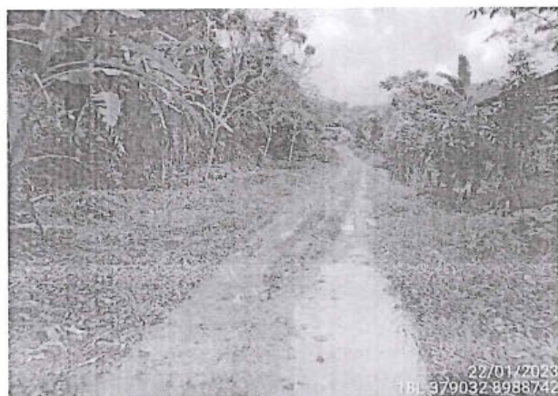
Foto 253: El tramo evaluado desde la prog. 4+500 a la prog. 5+000, presenta daños en la calzada de tipo Erosión, de nivel de gravedad: 3 alcanzando 0.80 m. de ancho de deterioro.
