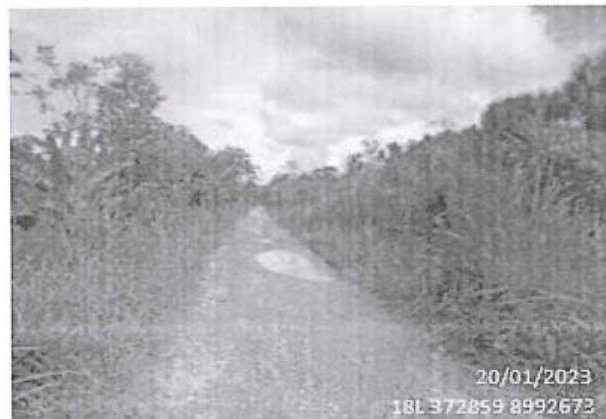
Foto 208: El tramo evaluado desde la prog. 00+099 a la prog. 0+389, presenta daños en la calzada de tipo Baches, encontrándose 3, de nivel de gravedad: 3.
