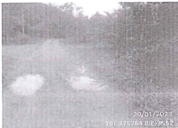
Foto 187: El tramo evaluado desde la prog. 43+477 a la prog. 43+515, presenta daños en la calzada de tipo Baches, encontrándose 3, de nivel de gravedad: 2.
