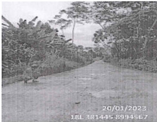
Foto 159: El tramo evaluado desde la prog. 03+327 a la prog. 03+480, presenta daños en la calzada de tipo Baches, encontrándose 10, de nivel de gravedad: 3.
