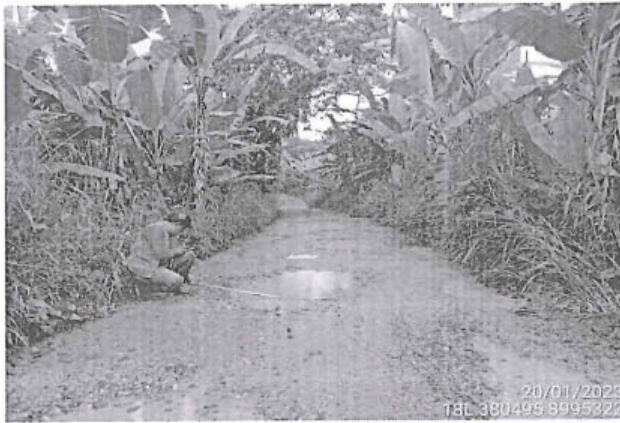
foto 153: El tramo evaluado desde la prog. 02+293 a la prog. 02+300, presenta daños en la calzada de tipo Baches, encontrándose 12, de nivel de gravedad: 2.
