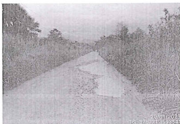
Foto 193: El tramo evaluado desde la prog. 45+124 a la prog. 45+130, presenta daños en la calzada de tipo Baches, encontrándose 12, de nivel de gravedad: 3.
