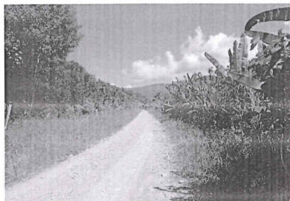
Foto 56: Superficie de rodadura de afirmado y estado de transitabilidad bueno, prog. 43+000
