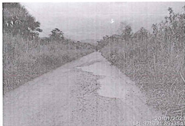
Foto 179: El tramo evaluado desde la prog. 40+913 a la prog. 41+023, presenta daños en la calzada de tipo Baches, encontrándose 15, de nivel de gravedad: 2.
