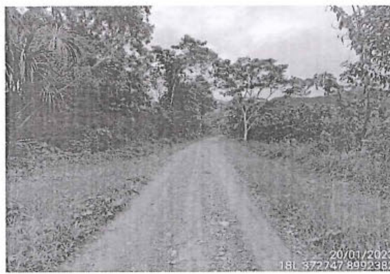
Foto 78: Superficie de rodadura de afirmado y estado de transitabilidad bueno, prog. 47+500
