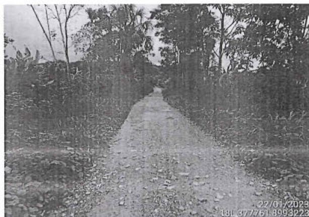
Foto 250: El tramo evaluado desde la prog. 3+500 a la prog. 3+740, presenta daños en la calzada de tipo Erosión, de nivel de gravedad: 3 alcanzando 1.00 m. de ancho de deterioro.
