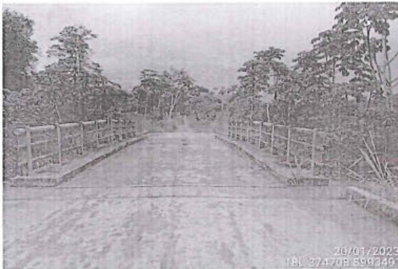
Foto 33: Puente, con Tablero de rodadura de Concreto en Buena Condición Funcional, Prog. 39+223
