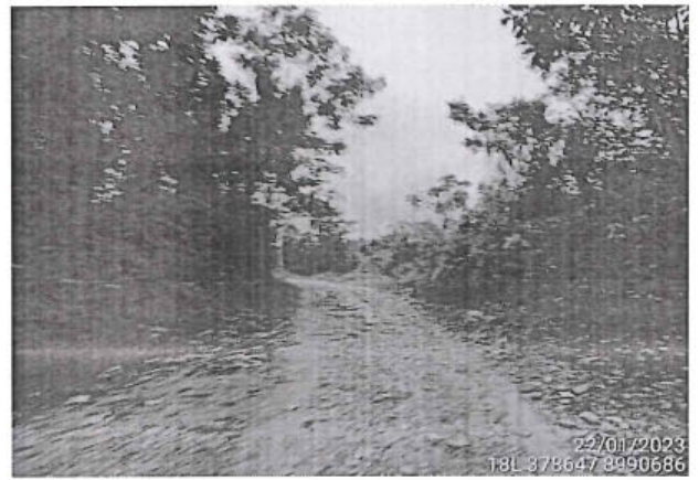
Foto 214: El tramo evaluado desde la prog. 1+240 a la prog. 1+500, presenta daños en la calzada de tipo Deformación, de nivel de gravedad: 3 alcanzando 1.60 m. de ancho de deterioro.
