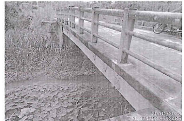
Foto 34: Puente, con Tablero de rodadura de Concreto en Buena Condición Funcional, Prog. 39+223
