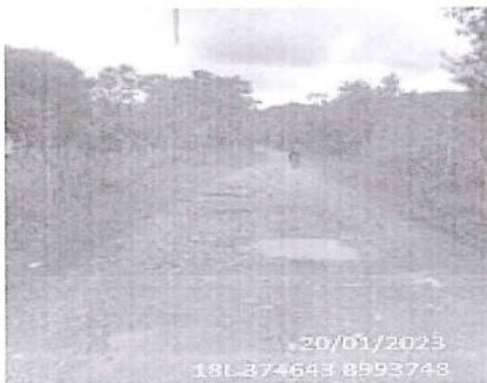
Foto 217: El tramo evaluado desde la prog. 02+195 a la prog. 02+200, presenta daños en la calzada de tipo Baches, encontrándose 8, de nivel de gravedad: 2.
