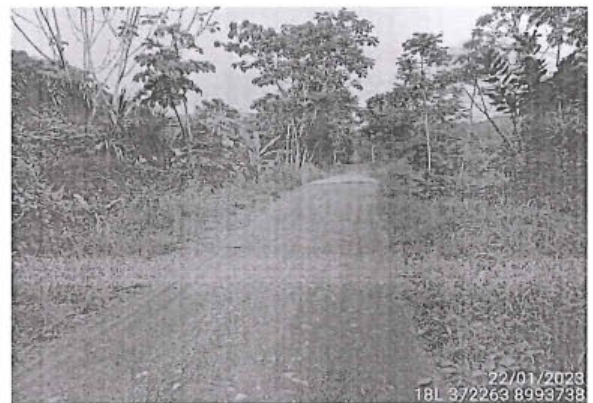
Foto 128: Superficie de rodadura de afirmado y estado de transitabilidad bueno, prog. 1+500
