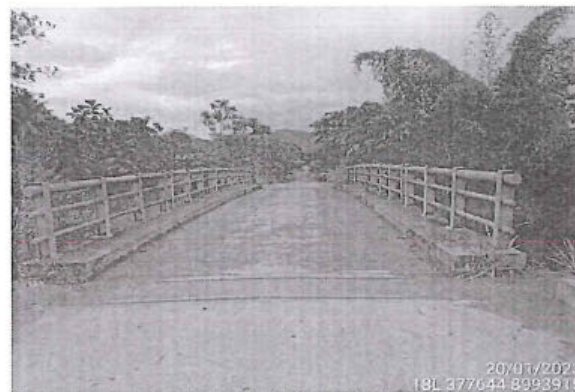
Foto 28: Puente, con Tablero de rodadura de Concreto en Buena Condición Funcional, Prog. 39+093
