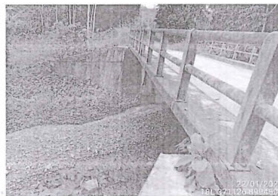
Foto 140: Puente, con Tablero de rodadura de Concreto en Buena Condición Funcional, Prog. 3+370
