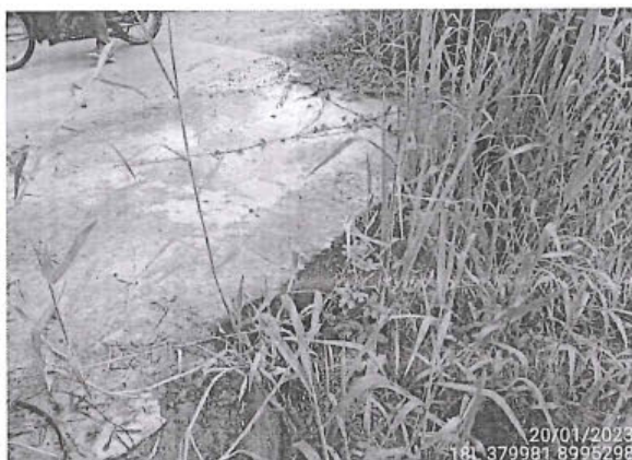
Foto 13: Alcantarilla de Concreto con tablero de rodadura de concreto, en buena condicion funcional y buen estado de conservación. Prog. 4+200
