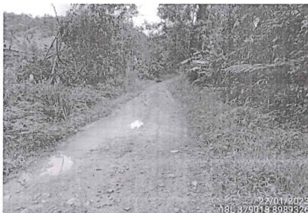
Foto 225: El tramo evaluado desde la prog. 3+384 a la prog. 03+390, presenta daños en la calzada de tipo Baches, encontrándose 6, de nivel de gravedad: 3.
