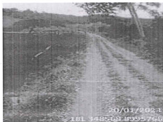
Foto 202: El tramo evaluado desde la prog. 46+860 a la prog. 47+000, presenta daños en la calzada de tipo Deformacion, de nivel de gravedad: 3 alcanzando 1.50 m. de ancho de deterioro.
