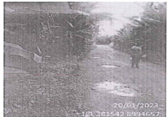
Foto 162: El tramo evaluado desde la prog. 03+802 a la prog. 03+980, presenta daños en la calzada de tipo Baches, encontrándose 6, de nivel de gravedad: 3.
