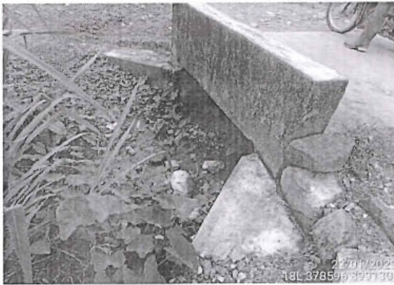
Foto 93: Alcantarilla de Concreto con tablero de rodadura de concreto, en buena condicion funcional y buen estado de conservación. Prog. 2+940
