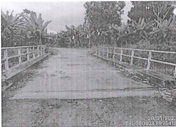
foto 7: Pontón, con Tablero de rodadura de Concreto en Buena Condición Funcional, Prog. 3+370
