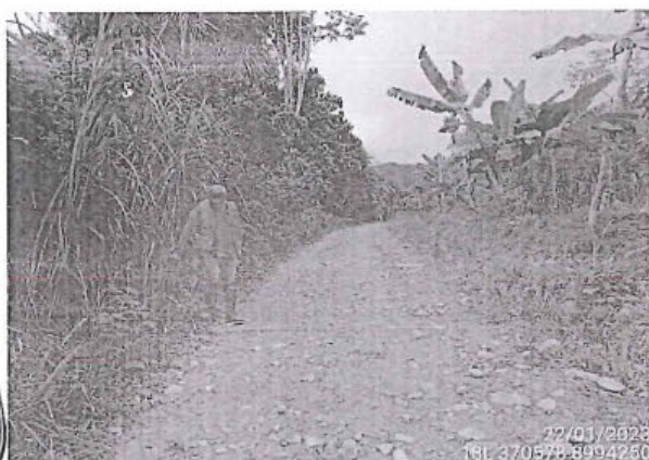
Foto 245: El tramo evaluado desde la prog. 2+145 a la prog. 2+360, presenta daños en la calzada de tipo Deformacion, de nivel de gravedad: 2 alcanzando 3.20 m. de ancho de deterioro.
