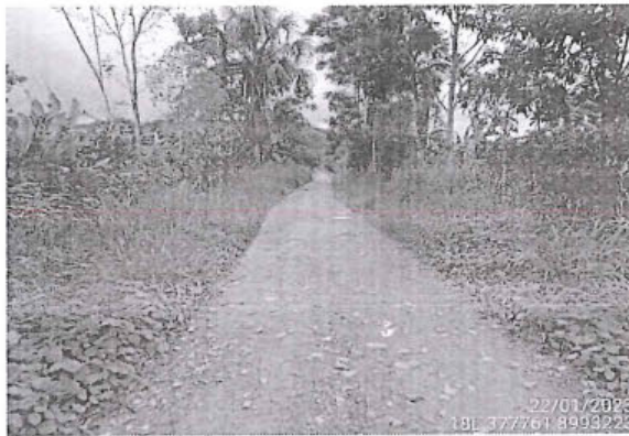
Foto 87: Superficie de rodadura de afirmado y estado de transitabilidad bueno, prog. 1+500
