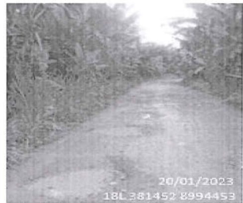
Foto 160: El tramo evaluado desde la prog. 03+490 a la prog. 03+500, presenta daños en la calzada de tipo Baches, encontrándose 9, de nivel de gravedad: 3.
