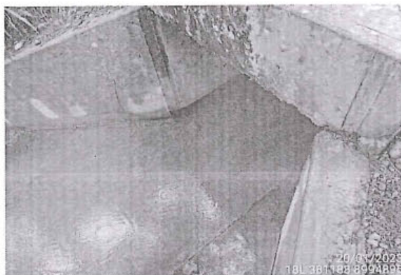
foto 5: Alcantarilla de Concreto con tablero de rodadura de concreto, en buena condicion funcional y buen estado de conservación. Prog. 2+770
