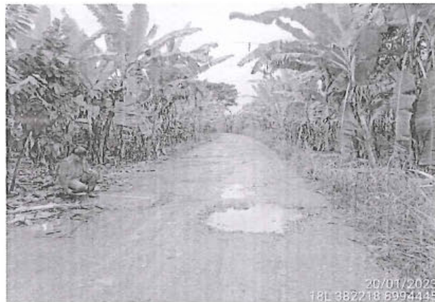
foto 148: El tramo evaluado desde la prog. 01+726 a la prog. 01+825, presenta daños en la calzada de tipo Baches, encontrándose 4, de nivel de gravedad: 2.
