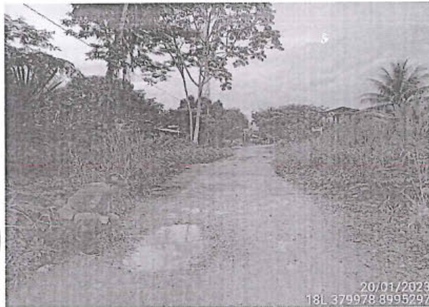
foto 155: El tramo evaluado desde la prog. 02+718 a la prog. 02+850, presenta daños en la calzada de tipo Baches, encontrándose 2, de nivel de gravedad: 2.
