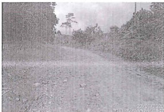
Foto 106: Superficie de rodadura de afirmado y estado de transitabilidad bueno, prog. 4+500
