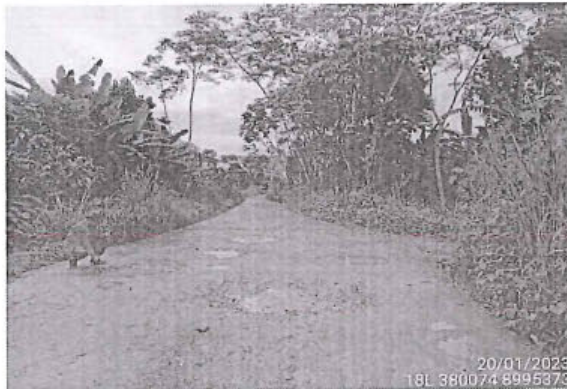
foto 9: Superficie de rodadura de afirmado y estado de transitabilidad bueno, prog. 3+500
