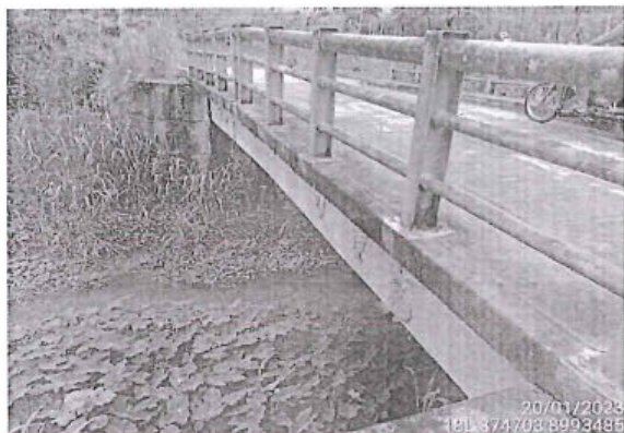
Foto 51: Puente, con Tablero de rodadura de Concreto en Buena Condición Funcional, Prog. 42+073
