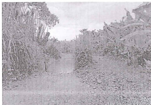
Foto 150: El tramo evaluado desde la prog. 01+840 a la prog. 01+850, presenta daños en la calzada de tipo Cruce de Agua, afectando todo el ancho de la vía (3.90 m.).
