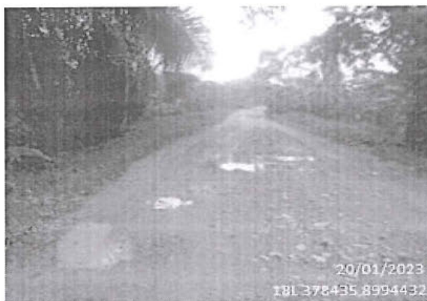
Foto 177: El tramo evaluado desde la prog. 40+316 a la prog. 40+468, presenta daños en la calzada de tipo Baches, encontrándose 11, de nivel de gravedad: 2.
