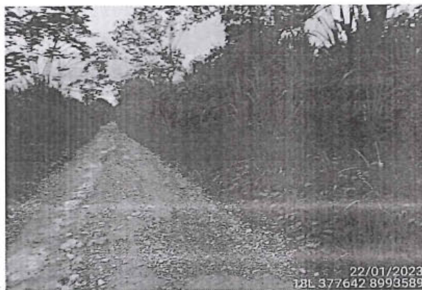
Foto 249: El tramo evaluado desde la prog. 3+100 a la prog. 3+500, presenta daños en la calzada de tipo Erosión, de nivel de gravedad: 3 alcanzando 0.60 m. de ancho de deterioro.
