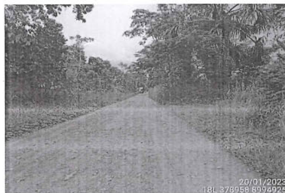
Foto 26: Superficie de rodadura de afirmado y estado de transitabilidad bueno, prog. 39+000
