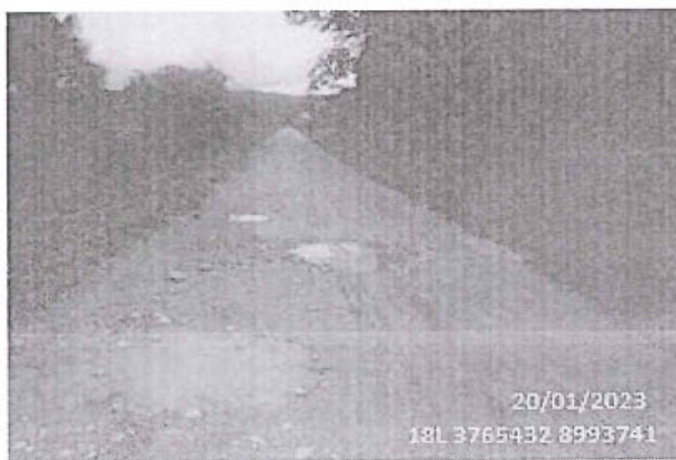
Foto 181: El tramo evaluado desde la prog. 41+455 a la prog. 41+560, presenta daños en la calzada de tipo Baches, encontrándose 8, de nivel de gravedad: 2.
