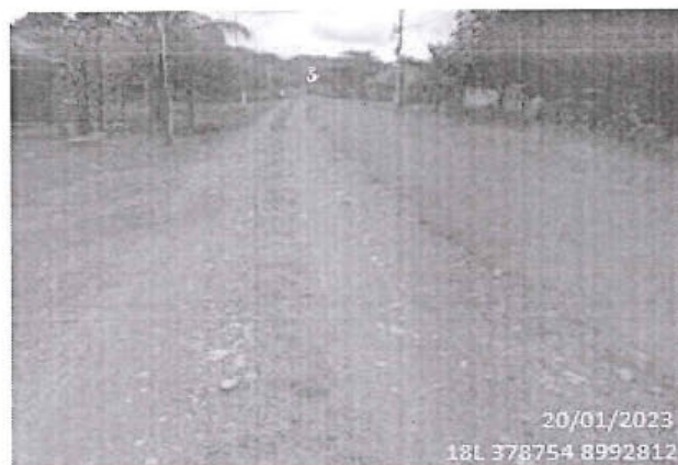
Foto 222: El tramo evaluado desde la prog. 1+840 a la prog. 2+940, presenta daños en la calzada de tipo Deformacion, de nivel de gravedad: 3 alcanzando 3.30 m. de ancho de deterioro.
