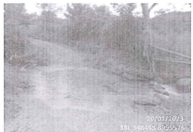
Foto 200: El tramo evaluado desde la prog. 46+315 a la prog. 46+330, presenta daños en la calzada de tipo Cruce de Agua, afectando todo el ancho de la vía (3.20 m.)
