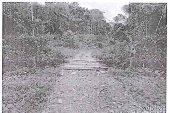
Foto 112: Alcantarilla, en regular condicion. Prog. 5+340
