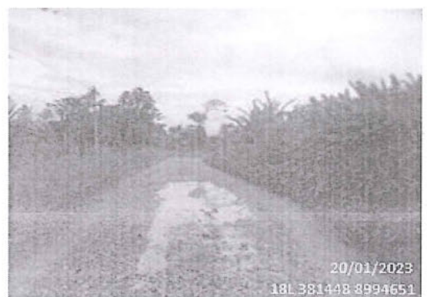
Foto 164: El tramo evaluado desde la prog. 04+160 a la prog. 04+365, presenta daños en la calzada de tipo Cruce de Agua, afectando todo el ancho de la vía (5.00 m.)
