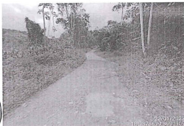
Foto 221: El tramo evaluado desde la prog. 02+824 a la prog. 02+830, presenta daños en la calzada de tipo Baches, encontrándose 8, de nivel de gravedad: 2.
