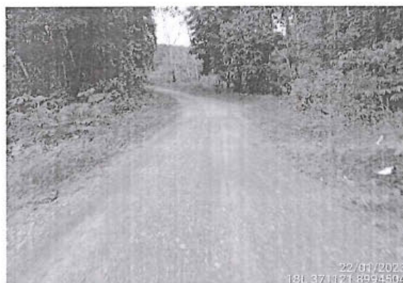
Foto 142: Superficie de rodadura de afirmado y estado de transitabilidad bueno, prog. 3+500
