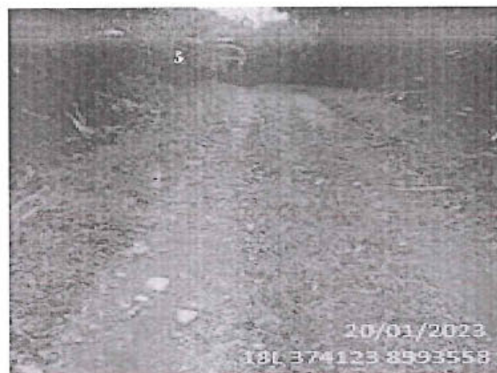
Foto 234: El tramo evaluado desde la prog. 5+350 a la prog. 5+500, presenta daños en la calzada de tipo Deformacion, de nivel de gravedad: 3 alcanzando 2.70 m. de ancho de deterioro.
