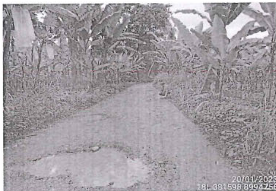
foto 3: Superficie de rodadura de afirmado y estado de transitabilidad regular, prog. 2+000
