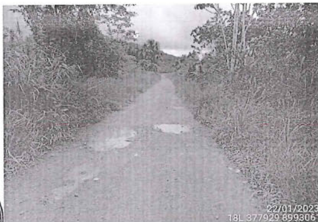
Foto 209: El tramo evaluado desde la prog. 00+497 a la prog. 0+500, presenta daños en la calzada de tipo Baches, encontrándose 9, de nivel de gravedad: 2.
