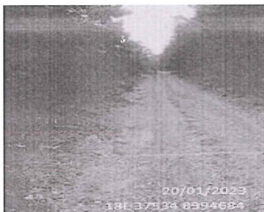
Foto 191: El tramo evaluado desde la prog. 44+500 a la prog. 44+640, presenta daños en la calzada de tipo Deformación, de nivel de gravedad: 3 alcanzando 2.70 m. de ancho de deterioro.
