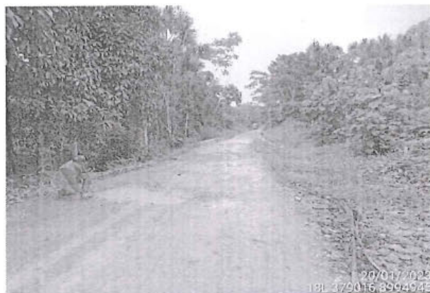
Foto 171: El tramo evaluado desde la prog. 38+490 a la prog. 38+720, presenta daños en la calzada de tipo Baches, encontrándose 40, de nivel de gravedad: 2.
