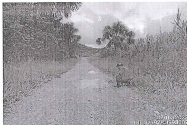
Foto 210: El tramo evaluado desde la prog. 0+788 a la prog. 0+890, presenta daños en la calzada de tipo Baches, encontrándose 7, de nivel de gravedad: 2.
