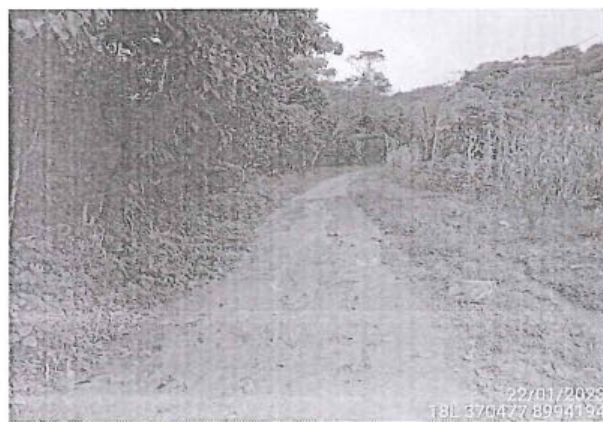
Foto 248: El tramo evaluado desde la prog. 2+960 a la prog. 3+100, presenta daños en la calzada de tipo Baches, encontrándose 17, de nivel de gravedad: 2.
