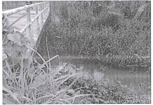
Foto 8: Pontón, con Tablero de rodadura de Concreto en Buena Condición Funcional, Prog. 3+370
