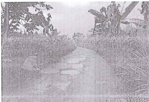
foto 151: El tramo evaluado desde la prog. 01+994 a la prog. 02+200, presenta daños en la calzada de tipo Baches, encontrándose 6, de nivel de gravedad: 2.
