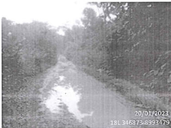
Foto 195: El tramo evaluado desde la prog. 45+436 a la prog. 45+440, presenta daños en la calzada de tipo Baches, encontrándose 8, de nivel de gravedad: 3.
