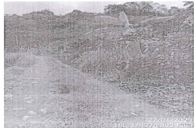
Foto 218: El tramo evaluado desde la prog. 2+200 a la prog. 2+498, presenta daños en la calzada de tipo Deformación, de nivel de gravedad: 3 alcanzando 0.90 m. de ancho de deterioro.
