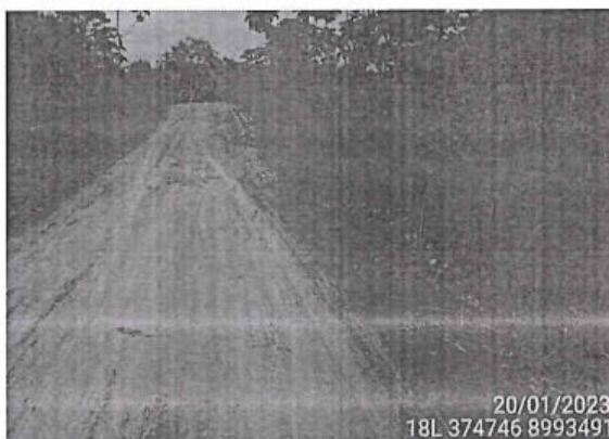
Foto 189: El tramo evaluado desde la prog. 43+600 a la prog. 44+000, presenta daños en la calzada de tipo Erosión, de nivel de gravedad: 3 alcanzando 1.80 m. de ancho de deterioro.
