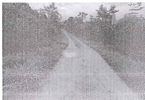
Foto 206: El tramo evaluado desde la prog. 00+019 a la prog. 0+026, presenta daños en la calzada de tipo Baches, encontrándose 1, de nivel de gravedad: 3.
