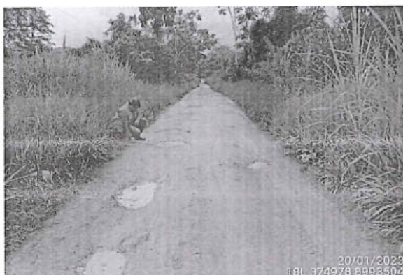
Foto 49: Superficie de rodadura de afirmado y estado de transitabilidad bueno, prog. 42+000
