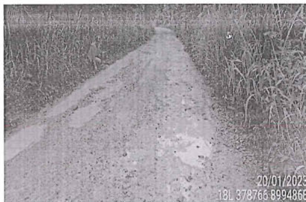
Foto 174: El tramo evaluado desde la prog. 39+493 a la prog. 39+500, presenta daños en la calzada de tipo Baches, encontrándose 12, de nivel de gravedad: 2.
