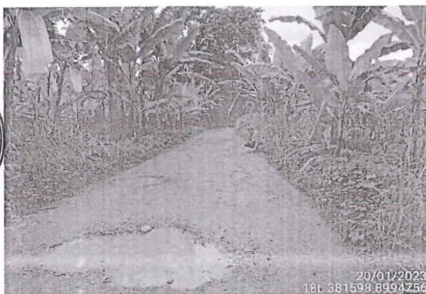
foto 149: El tramo evaluado desde la prog. 01+839 a la prog. 01+840, presenta daños en la calzada de tipo Baches, encontrándose 8, de nivel de gravedad: 2.
