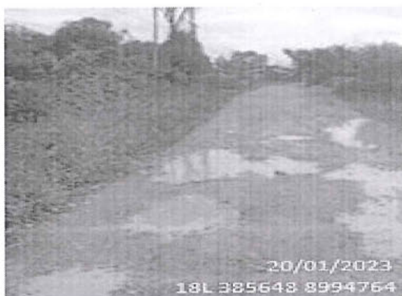
foto 165: El tramo evaluado desde la prog. 04+488 a la prog. 04+569, presenta daños en la calzada de tipo Baches, encontrándose 11, de nivel de gravedad: 2.
