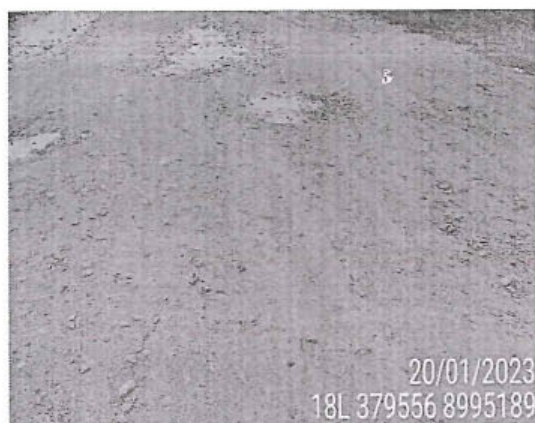
foto 167: El tramo evaluado desde la prog. 36+994 a la prog. 37+385, presenta daños en la calzada de tipo Baches, encontrándose 153, de nivel de gravedad: 2.
