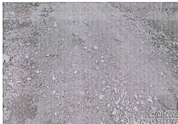
Foto 246: El tramo evaluado desde la prog. 2+360 a la prog. 2+460, presenta daños en la calzada de tipo Erosión, de nivel de gravedad: 3 alcanzando 1.10 m. de ancho de deterioro.
