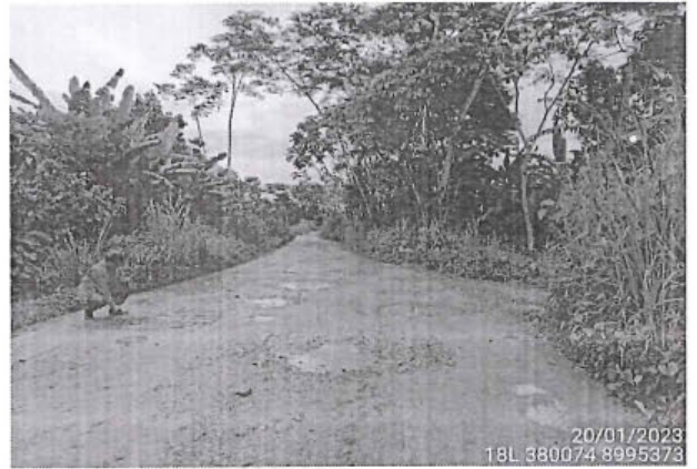
Foto 154: El tramo evaluado desde la prog. 02+494 a la prog. 02+500, presenta daños en la calzada de tipo Baches, encontrándose 4, de nivel de gravedad: 3.
