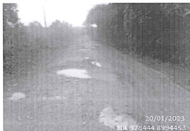
Foto 178: El tramo evaluado desde la prog. 40+492 a la prog. 40+500, presenta daños en la calzada de tipo Baches, encontrándose 8, de nivel de gravedad: 2.
