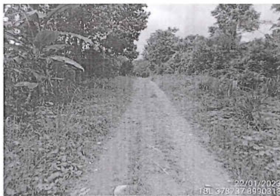
Foto 102: Superficie de rodadura de afirmado y estado de transitabilidad bueno, prog. 4+000
