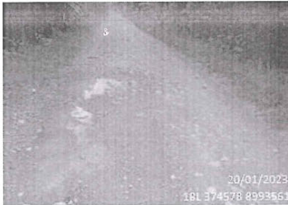
Foto 215: El tramo evaluado desde la prog. 01+768 a la prog. 01+790, presenta daños en la calzada de tipo Baches, encontrándose 6, de nivel de gravedad: 2.
