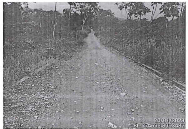
Foto 196: El tramo evaluado desde la prog. 45+500 a la prog. 45+700, presenta daños en la calzada de tipo Deformacion, de nivel de gravedad: 3 alcanzando 2.80 m. de ancho de deterioro.
