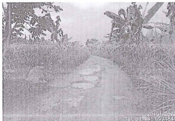
Foto 152: 25 El tramo evaluado desde la prog. 02+205 a la prog. 02+220, presenta daños en la calzada de tipo Baches, encontrándose 18, de nivel de gravedad: 3.
