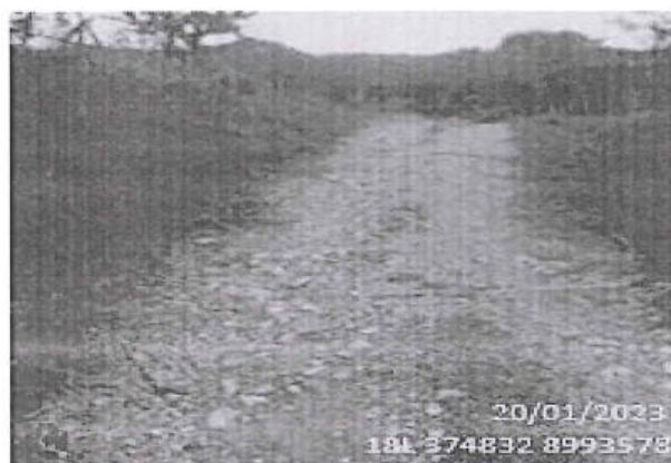
Foto 190: El tramo evaluado desde la prog. 44+000 a la prog. 44+340, presenta daños en la calzada de tipo Erosión, de nivel de gravedad: 3 alcanzando 3.10 m. de ancho de deterioro.
