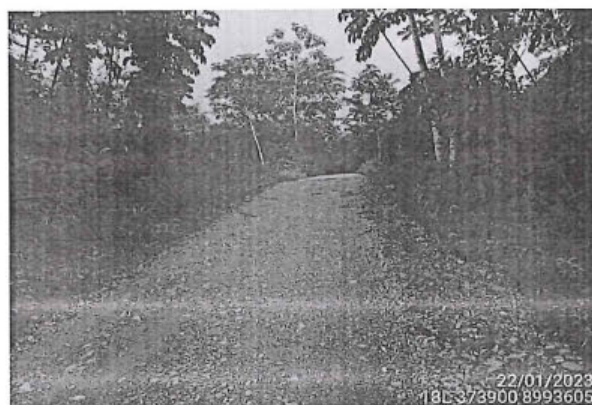
Foto 232: El tramo evaluado desde la prog. 4+770 a la prog. 4+870, presenta daños en la calzada de tipo Erosión, de nivel de gravedad: 3 alcanzando 2.70 m. de ancho de deterioro.
