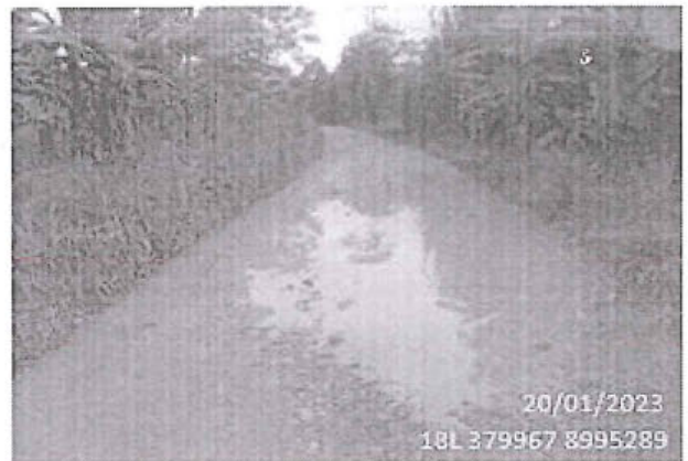
Foto 156: El tramo evaluado desde la prog. 02+877 a la prog. 02+970, presenta daños en la calzada de tipo Baches, encontrándose 2, de nivel de gravedad: 3.
