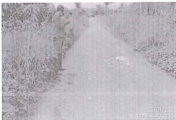
Foto 175: El tramo evaluado desde la prog. 39+695 a la prog. 39+965, presenta daños en la calzada de tipo Baches, encontrándose 27, de nivel de gravedad: 2.
