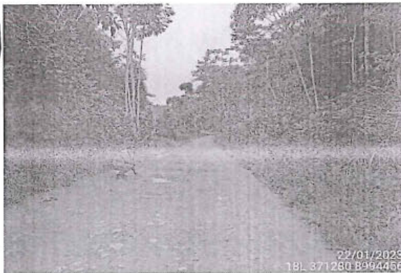
Foto 137: Superficie de rodadura de afirmado y estado de transitabilidad bueno, prog. 3+000
