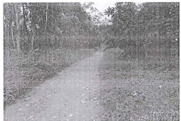
Foto 96: Superficie de rodadura de afirmado y estado de transitabilidad bueno, prog. 3+500
