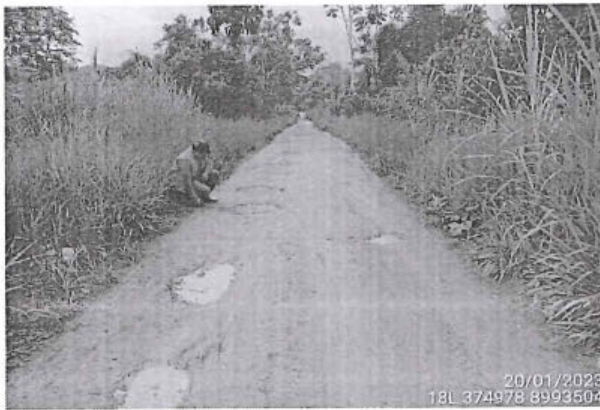
Foto 183: El tramo evaluado desde la prog. 42+263 a la prog. 42+389, presenta daños en la calzada de tipo Baches, encontrándose 12, de nivel de gravedad: 2.
