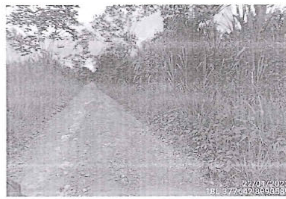
Foto 84: Superficie de rodadura de afirmado y estado de transitabilidad bueno, prog. 0+500
