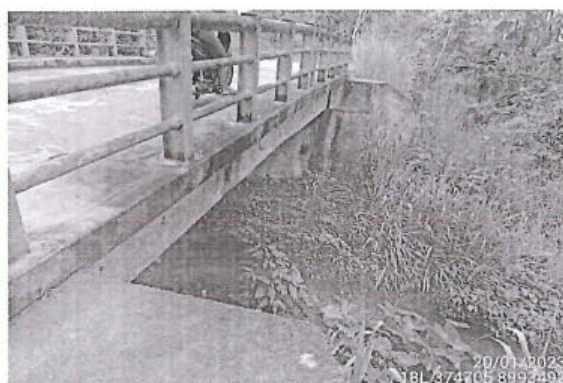
Foto 52: Puente, con Tablero de rodadura de Concreto en Buena Condición Funcional, Prog. 42+073
