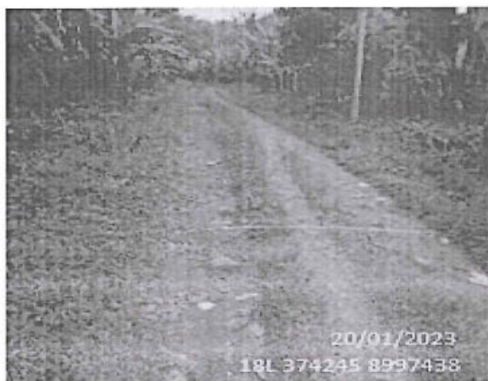
Foto 237: El tramo evaluado desde la prog. 6+000 a la prog. 6+180, presenta daños en la calzada de tipo Deformacion, de nivel de gravedad: 3 alcanzando 2.70 m. de ancho de deterioro.
