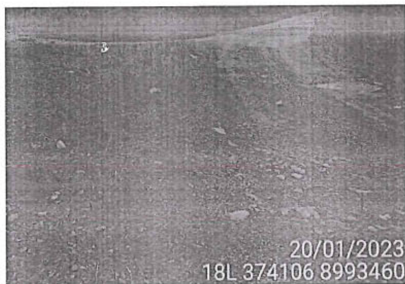
Foto 233: El tramo evaluado desde la prog. 5+000 a la prog. 5+350, presenta daños en la calzada de tipo Erosión, de nivel de gravedad: 3 alcanzando 2.70 m. de ancho de deterioro.
