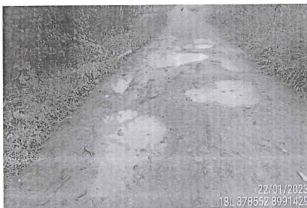
Foto 219: El tramo evaluado desde la prog. 02+499 a la prog. 02+599, presenta daños en la calzada de tipo Baches, encontrándose 3, de nivel de gravedad: 3.
