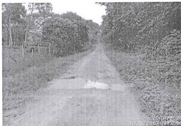
Foto 207: El tramo evaluado desde la prog. 0+028 a la prog. 0+081, presenta daños en la calzada de tipo Cruce de Agua, afectando todo el ancho de la vía (2.90 m.)
