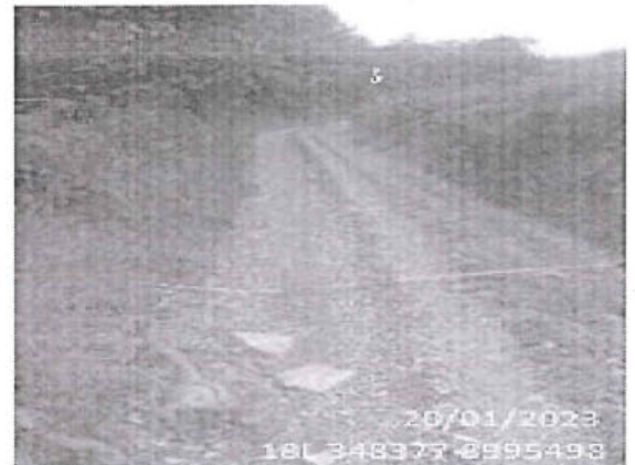
Foto 198: El tramo evaluado desde la prog. 46+000 a la prog. 46+270, presenta daños en la calzada de tipo Deformacion, de nivel de gravedad: 3 alcanzando 2.80 m. de ancho de deterioro.
