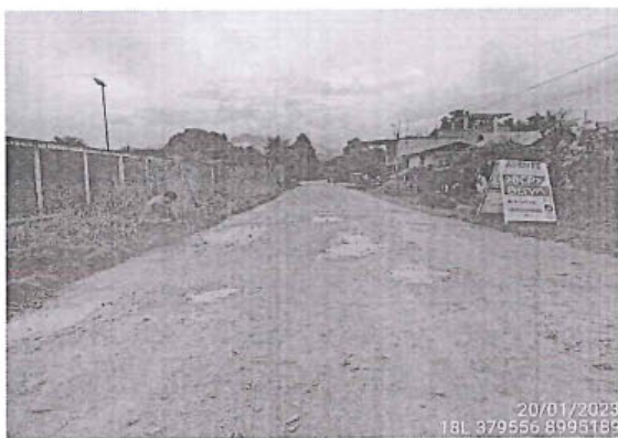
Foto 15: Superficie de rodadura de afirmado y estado de transitabilidad bueno, prog. 4+500
