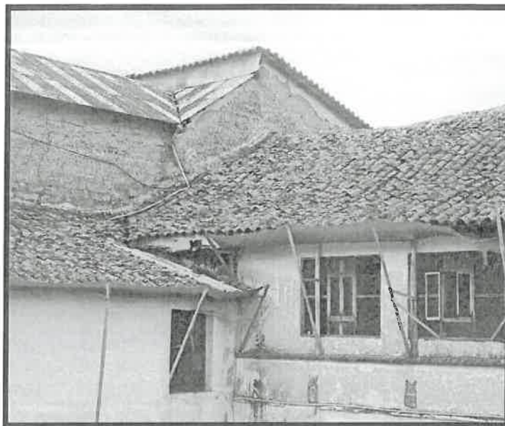
Fig. 02: Vista de caña y barro deteriorada en cobertura de techo.
