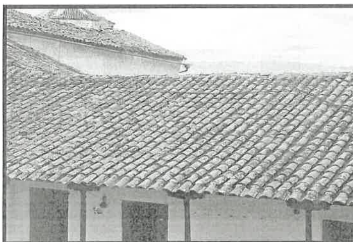
Fig. 01: Vista de líquen y humedad en cobertura de techo.
