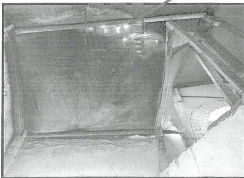
Fig. 03: Se muestra el desprendimiento del techo debido a la filtración de aguas pluviales.
