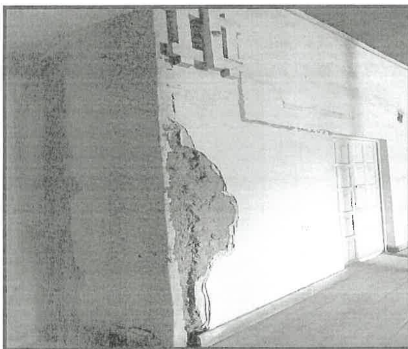
Fig. 05: Se observa fisuras en las paredes.
