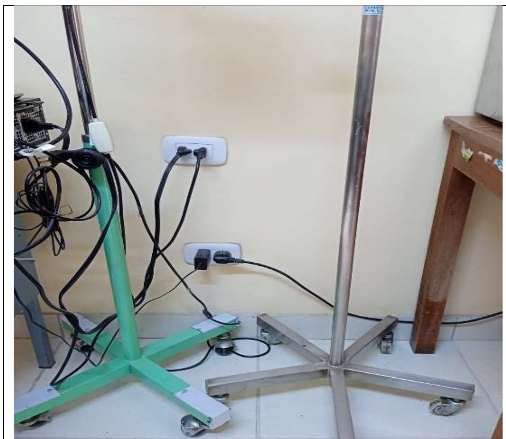
Fotografía 8. Se observa cables eléctricos expuestos
