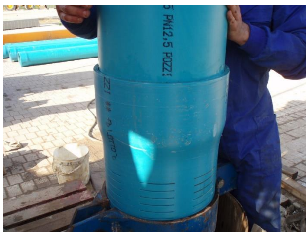
Foto N° 8,, Colocación de la Tubería de PVC en el pozo tubular
