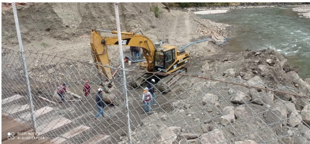
Foto N° 2, Limpieza y Nivelación del área donde se realizará la perforación
