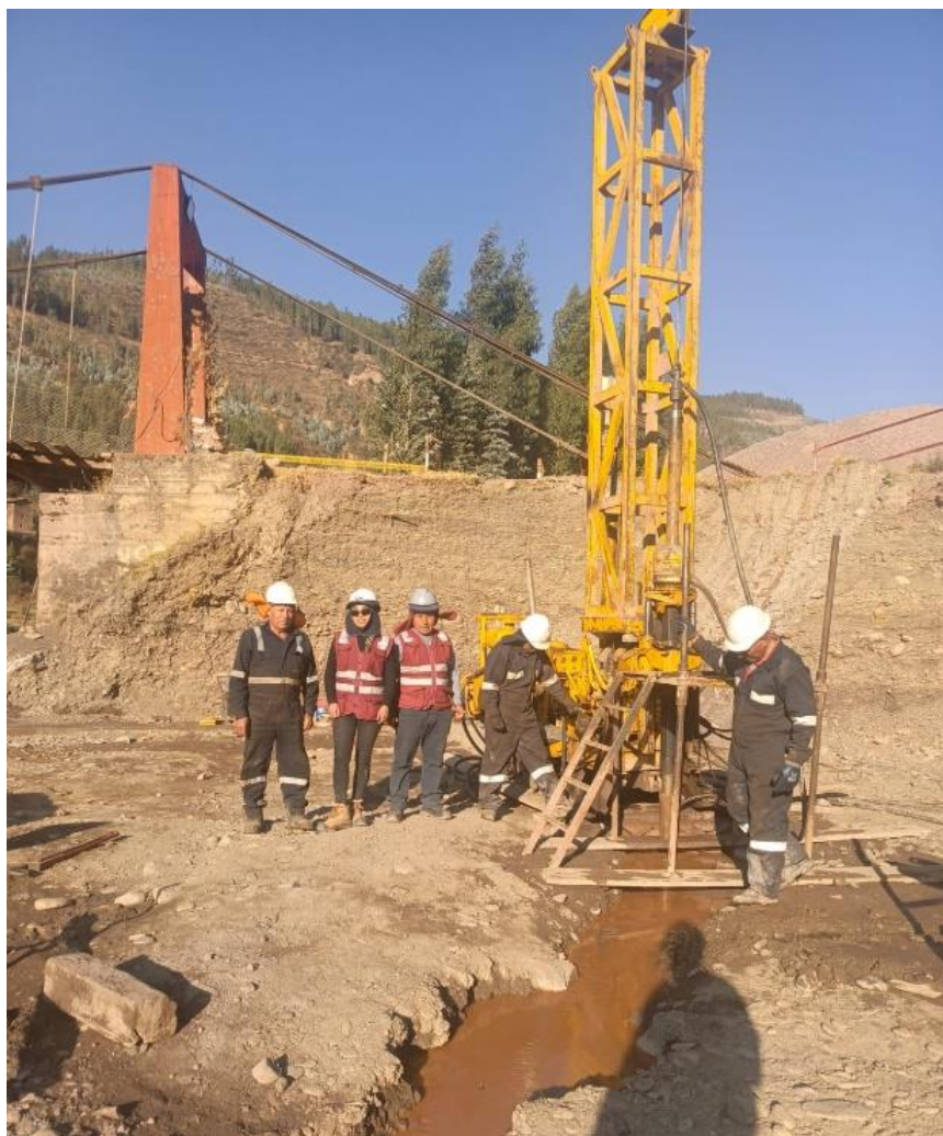
Foto N° 7, Perforación del Pozo Tubular
