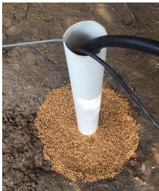
Foto N° 9,, Colocación del filtro en el pozo Tubular
