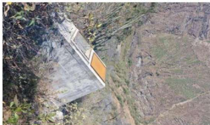
Fotografía: Cámara rompe presión N° 02.
