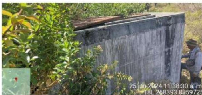
Fotografía: Cámara rompe presión N° 01.
