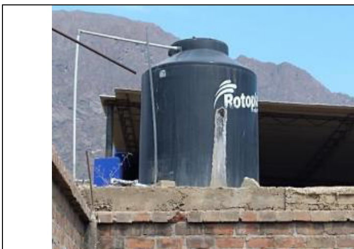
Foto N° 04: Techo de SS.HH. presenta pandeo en la superficie debido a las cargas generadas por el tanque elevado de 1100ml.
