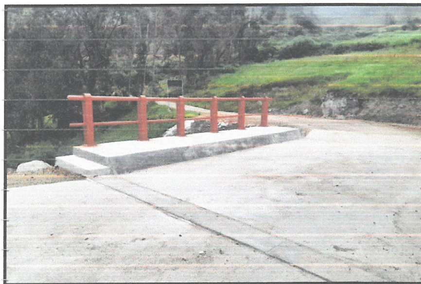
Ilustración N° 01: Se observa la Losa de Concreto Armado, Veredas de 1.25m a cada lado
