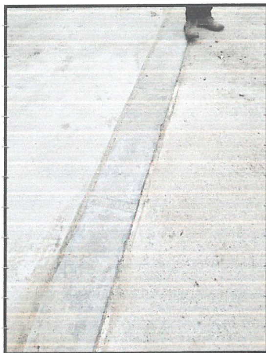
Ilustración N° 04: Se puede observar la colocación de la Lámina de Junta de Dilatación Según Diseño
