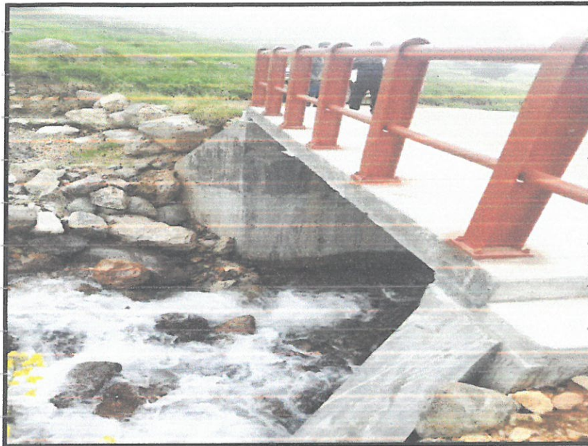
Ilustración N° 02: Se Observa las Aletas a cada lado, Barandas de F°G
