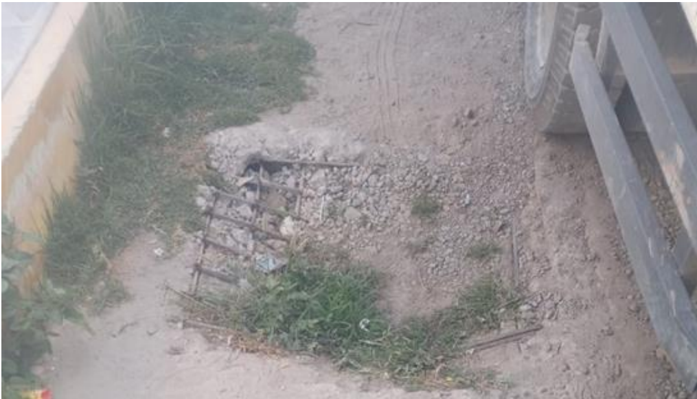
VISIA 01: Deterioro de tapa y mantenimiento pozos a tierra
