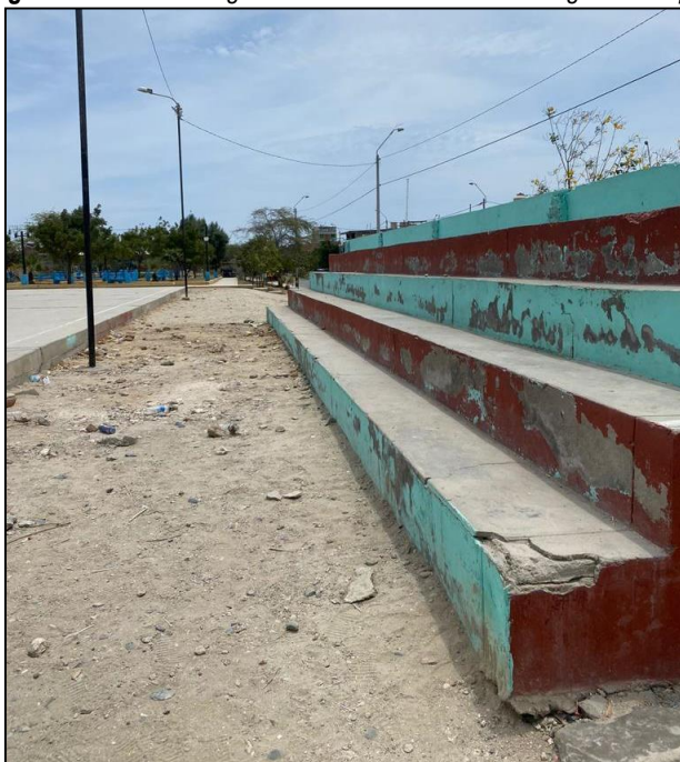
Imagen N°02: Gradas agrietadas con estructura en riesgo de colapso.
