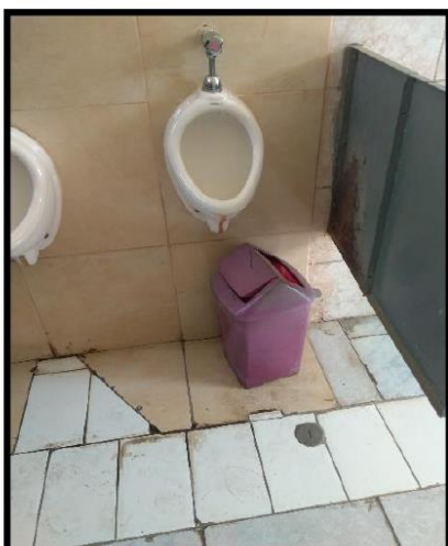
Fotografía 05 y 06: Cerámica de piso y pared parchados; separadores de inodoros y urinario oxidados
