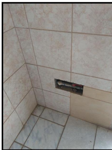
Fotografía 07: Válvula de control deteriorado
