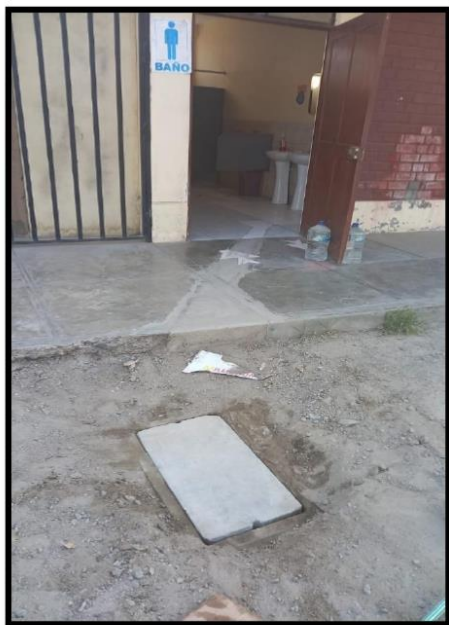
Fotografía 15: Caja de desagüe existente a rehabilitar
