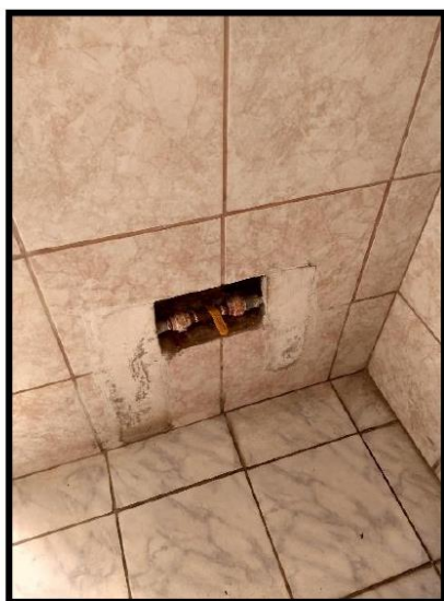
Fotografía 09: Válvula de control de inodoros deteriorado
