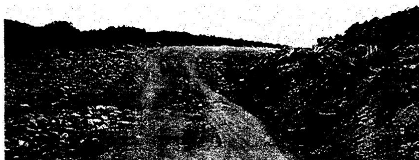
¶Foto N° 03: Falla por presencia de baches (huecos) y acumulación de aguas pluviales
