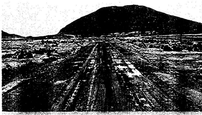
Foto N° 05 Presencia de lodazales, provocando deformaciones en la vía
