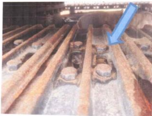
Foto N°06 Pernos de la zapata a ser remplazados.
