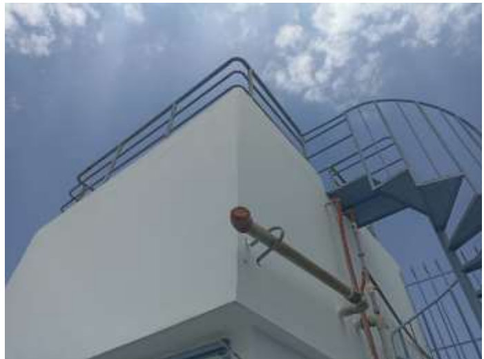
PINTADO DE CARPINTERÍA METÁLICA EN ZONA DE TANQUE ELEVADO
