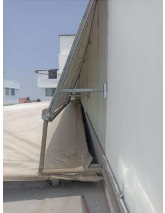
DESMONTAJE Y ELIMINACIÓN DE ESTRUCTURA DE PERFILES DE ALUMINIO Y COBERTURA DE POLICARBONATO EN AZOTEA DE CASONA
