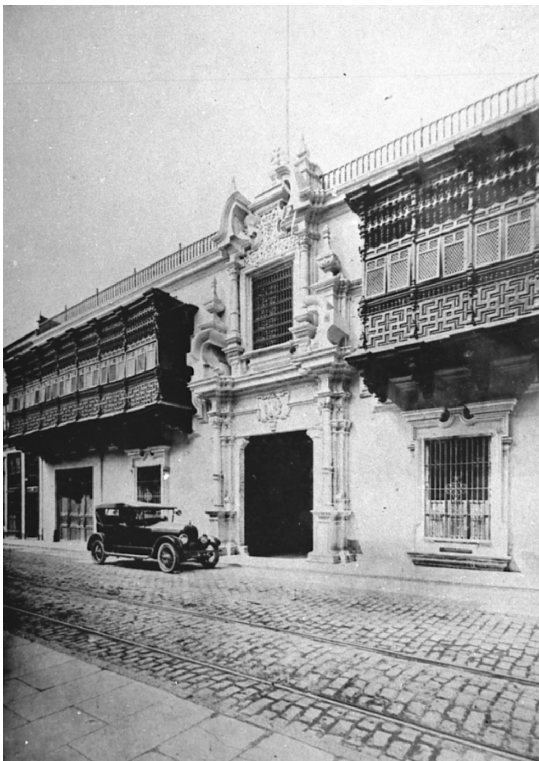
Figura 11. Fachada de Torre Tagle, fecha desconocida, posiblemente entre 1920 y 1930. Se observan los jambajes de las ventanas en el primer nivel, con peanas, molduras convexas, pilastras y una cornisa mixtilínea. Fuente: Archivo PROLIMA.
