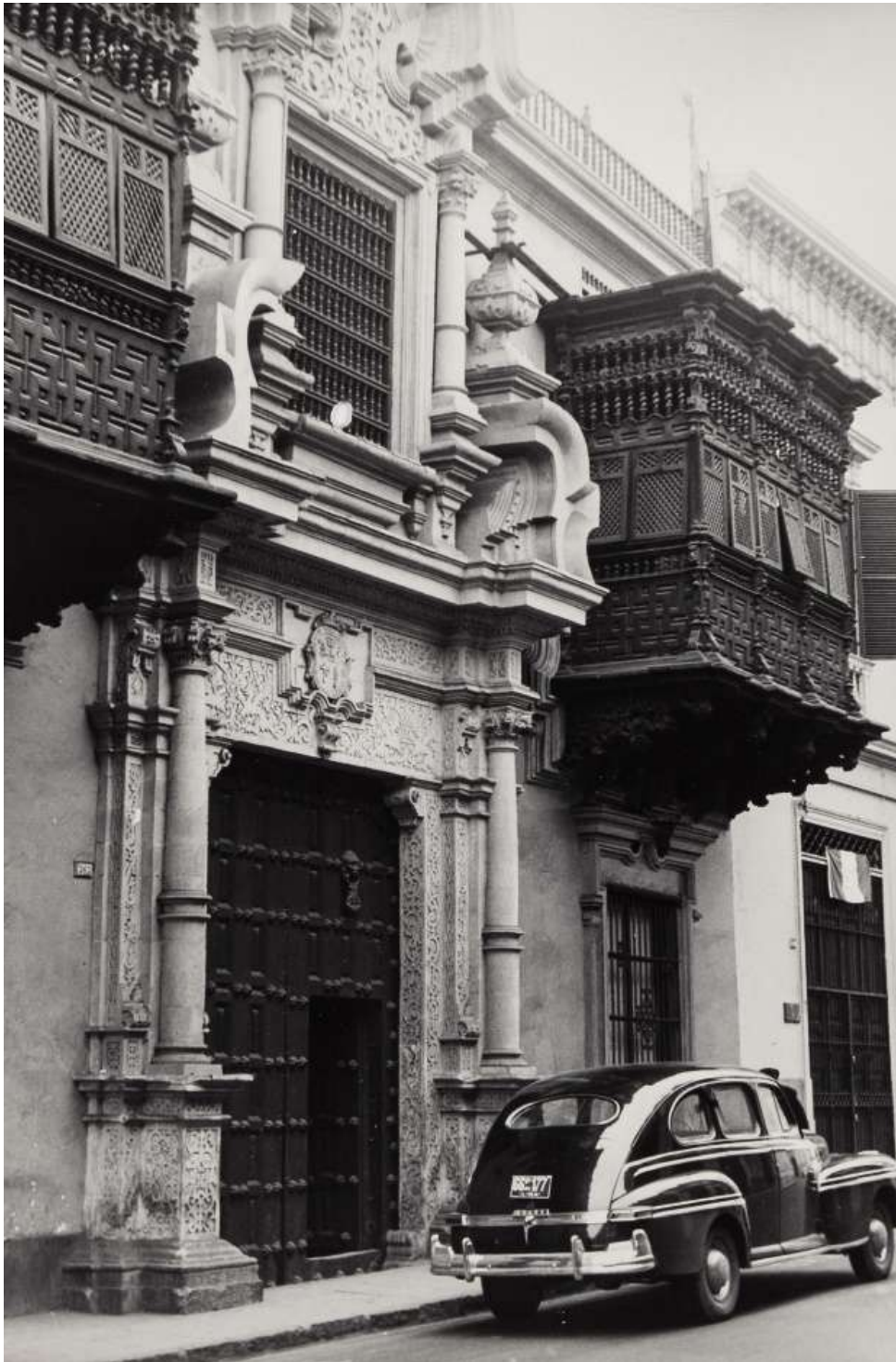
Figura 14. Fachada de Torre Tagle, fecha desconocida, posiblemente entre 1920 y 1930. Se ve reintegrado el escudo en la portada, la ventana de la portada en el segundo nivel tiene carpintería ornamental de madera y los balcones tienen celosías. También se pueden ver manchas de humedad en la parte baja de los muros y los pedestales. Fuente: Archivo Histórico Riva-Agüero. Pontificia Universidad Católica del Perú. Recuperado de: http://repositorio.pucp.edu.pe/index/handle/123456789/70909
