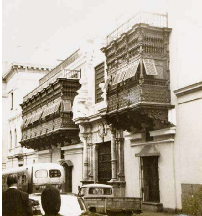
Figura 15. Fachada de Torre Tagle, año 1971. Los balcones de cajón aparecen con balaustres de remate. Fuente: Archivo Histórico Riva-Agüero. Pontificia Universidad Católica del Perú. Recuperado de: http://repositorio.pucp.edu.pe/index/handle/123456789/35066
