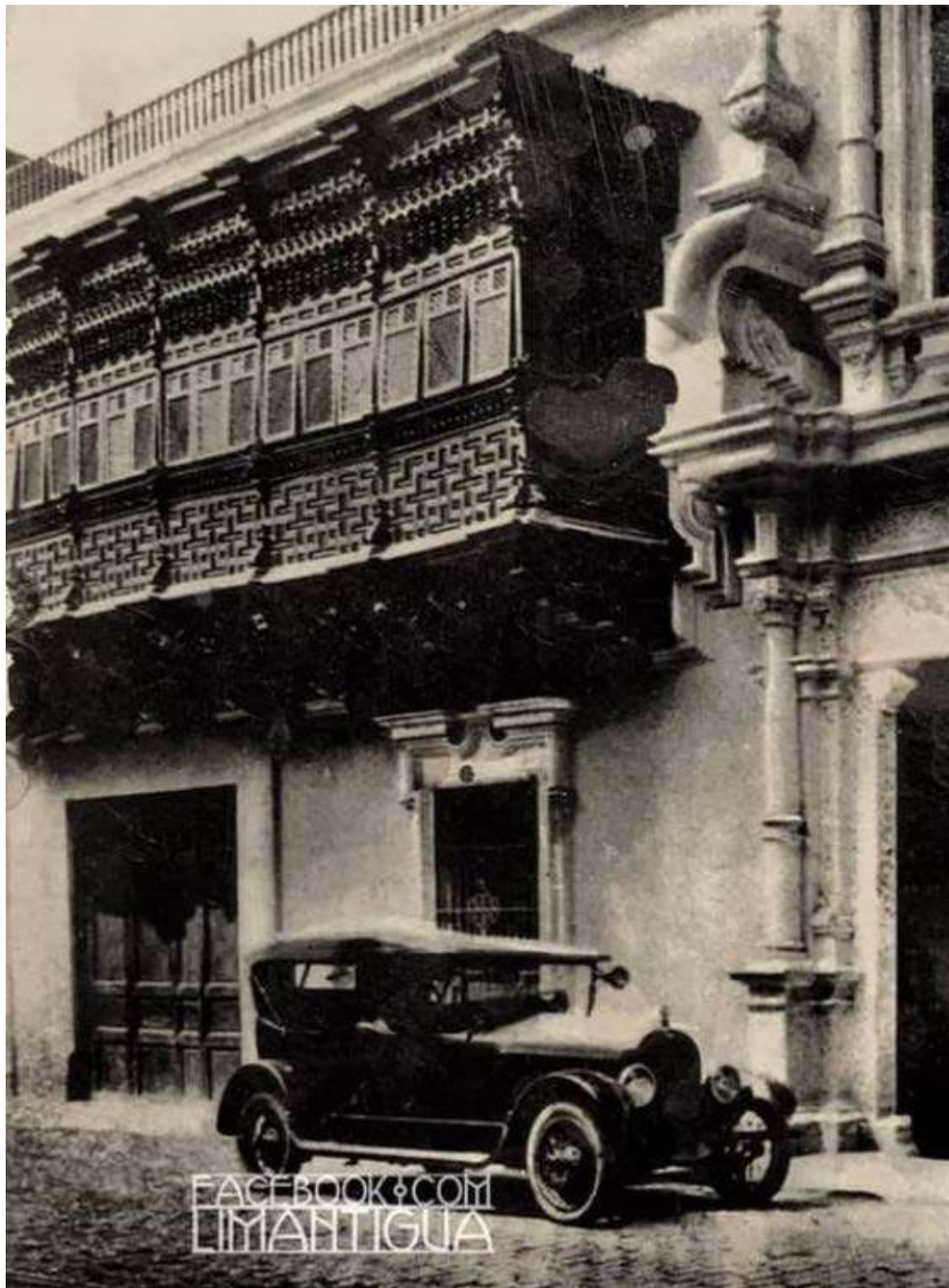
Figura 10. Fachada de Torre Tagle, aproximadamente 1920. Para esta fecha la tipología de las ventanas ha cambiado, se observa el jambaje de la primera ventana en el primer nivel, con peanas, molduras convexas, pilastras y una cornisa mixtilínea. Con carpintería metálica en la que predominan las líneas verticales. Fuente: Lima Antigua.
