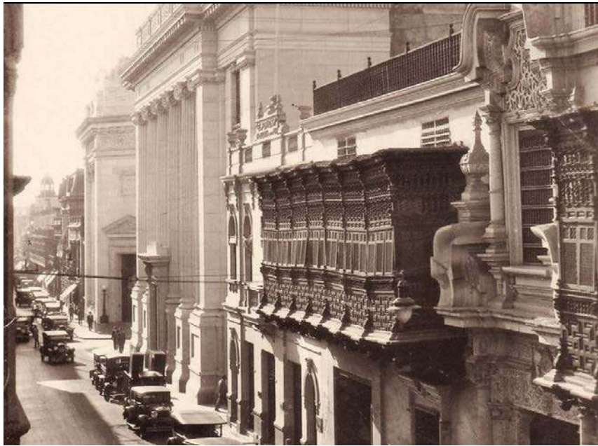
Figura 12. Fachada de Torre Tagle, aproximadamente 1920. Se ve reintegrado el escudo en la portada, la ventana de la portada en el segundo nivel tiene carpintería ornamental de madera y los balcones tienen celosías. Fuente: Lima Antigua. Recuperado de: https://www.facebook.com/limantigua/photos/a.145414555489908/1355020157862669
