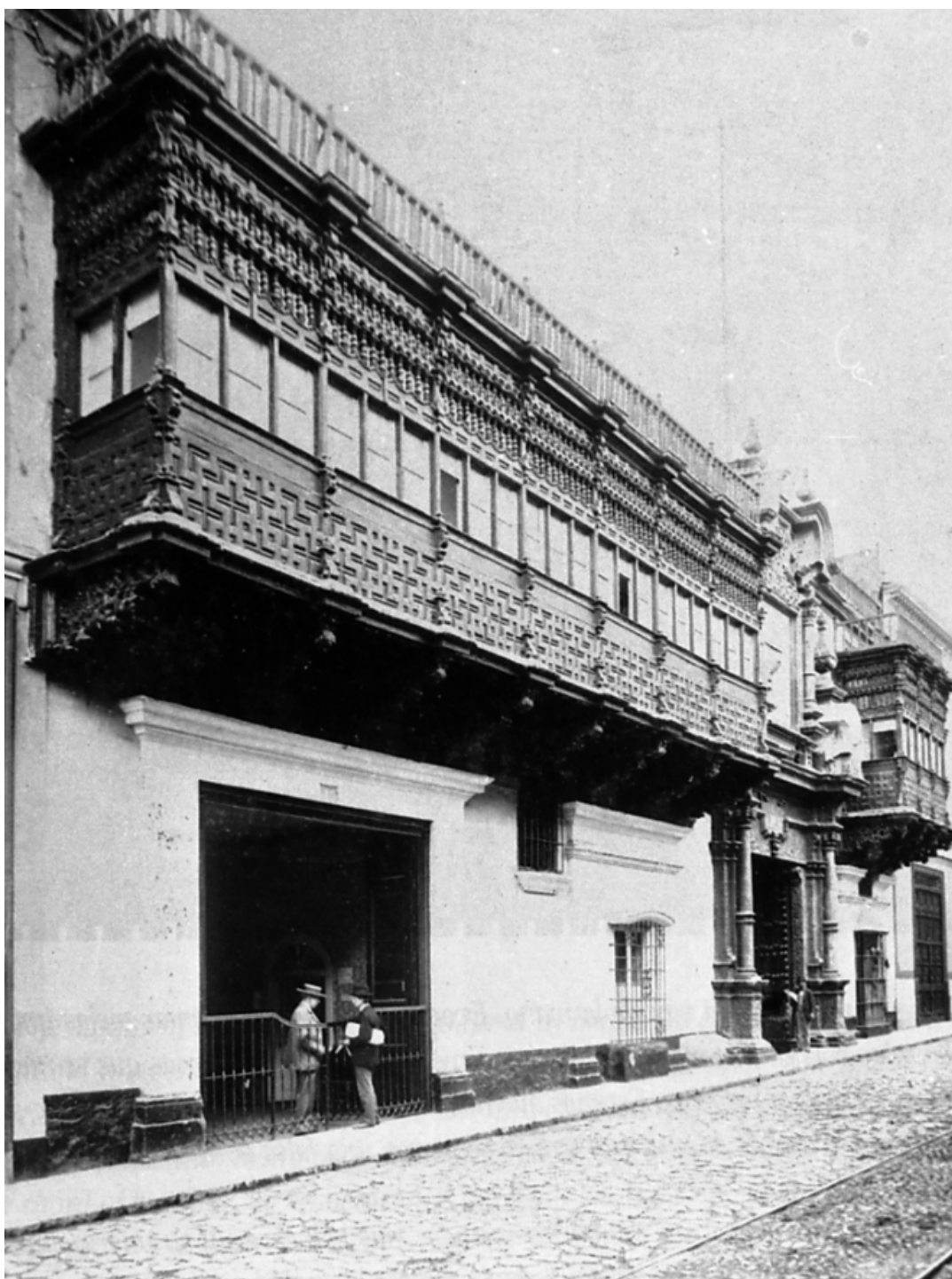
Figura 7. Palacio de Torre Tagle, año desconocido, posiblemente a finales del siglo XIX. No tenía la ornamentación del escudo en la portada ni celosías en los balcones. La primera ventana, de izquierda a derecha, aún estaba dispuesta como una tienda, las otras dos se habían adaptado como ventanas con peana. Fuente: Archivo PROLIMA.
