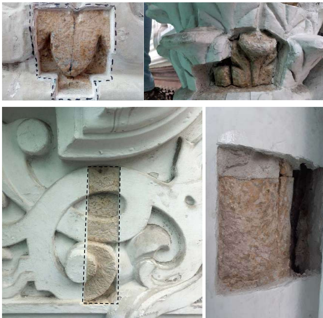
Figura 33, 34, 35 y 36. Vestigios de estuco tipo marmolina en el segundo cuerpo de la fachada de Torre Tagle. Fuente: PROLIMA.
