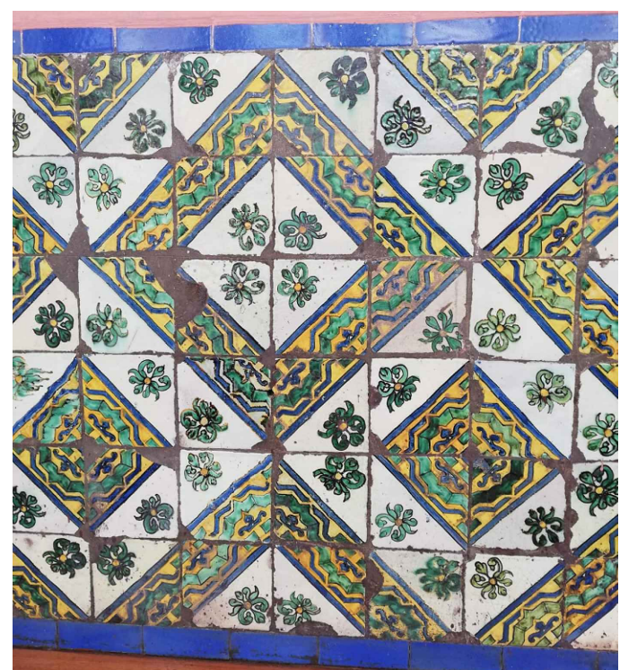
Fotografía 3. Azulejos al interior del balcón B1, con desgaste en su acabado y rejunteo con acabado oscurecido.
