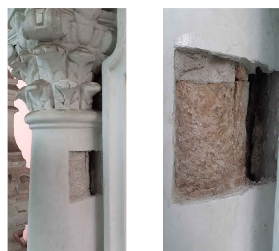
Fotografía 2. Fuste de columna en el segundo cuerpo de Torre Tagle, en el que se observa el estuco original con acabado tipo marmolina. Oculto tras capas de yeso de naturaleza posterior.
