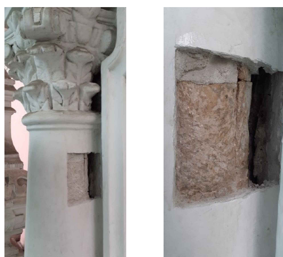
Fotografía 2. Fuste de columna en el segundo cuerpo de Torre Tagle, en el que se observa el estuco original con acabado tipo marmolina. Oculto tras copas de yeso de naturaleza posterior.
