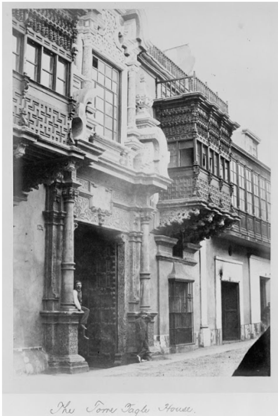
Figura 5. Fachada de Torre Tagle, 1868. El nivel del zócalo aparece más alto, casi a la mitad del pedestal de la portada. No aparece el escudo encima del portón de acceso. En la parte superior de la portada es posible ver una textura marmoleada en los fustes, peana y molduras. Fuente: Library of Congress Prints and Photographs Division Washington, D.C. Recuperado de: http://perusigloxix.blogspot.com/2013/06/casa-torre-tagle.html
