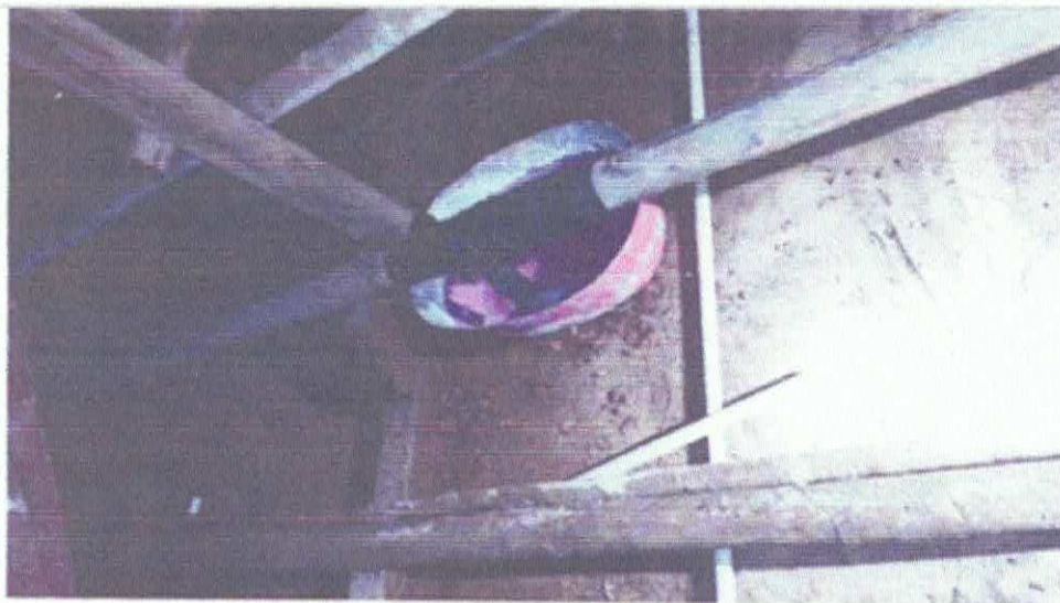
FOTO N° 4: Se aprecia estado actual de la tubería, la cual se encuentra en presencia de oxido y dañada a causa de la falta de mantenimiento.
