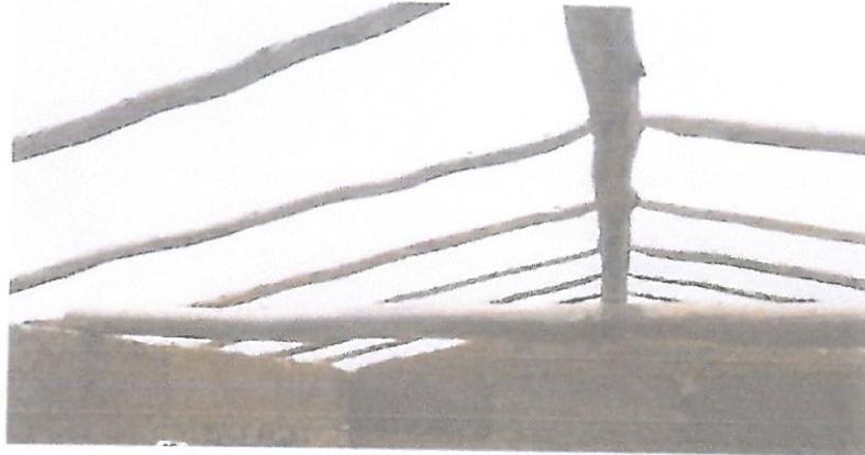
**MADERA ROLLIZA DE 2.5" DE DIÁMETRO X 3.20 MTS (SOPORTE DE LA CUBIERTA O AGROFILM) INCLUYE 30 CM DE ALERO**
