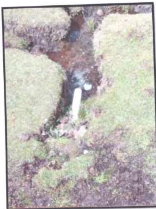
FOTOGRAFIA N° 02 ANULAR LA TUBERÍA DE PVC DE REBOSE DE 2"
