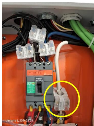
Transformador de corriente existente en el tablero estabilizado del CDS
