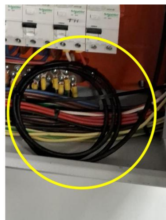
Transformador de corriente existente en el tablero estabilizado del CDS
