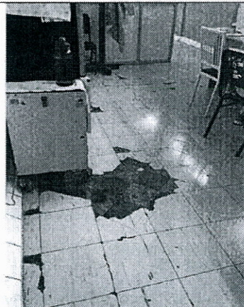
Foto N° 02: LOS PISOS EXISTENTES DEL PASILLO, SERÁN CAMBIADOS POR PISO PORCELANATO DE 0.60m x 0.60m
