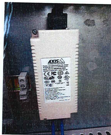
Foto N°23: Placa de POE para camara Axis
