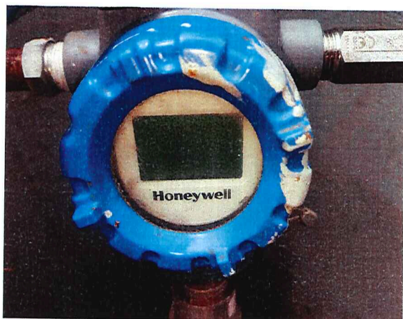
Foto N°22: Humedad en pantalla de transmisores Hart.
