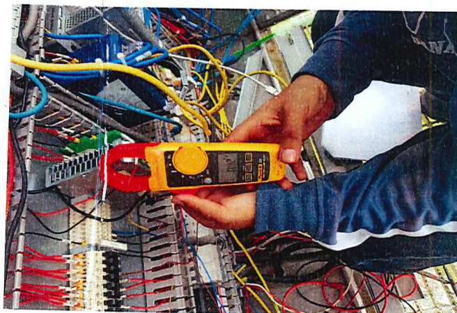
Foto N°21: Consumo salida de Fuente 12 Vdc: 420 mAdc
