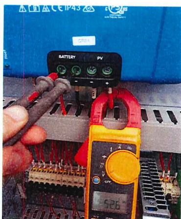
Foto N°26: Tensión de salida de regulador de
