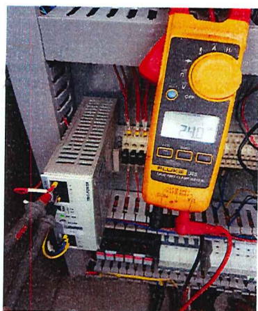
Foto N°24: Tensión de fuente 24 Vdc:
