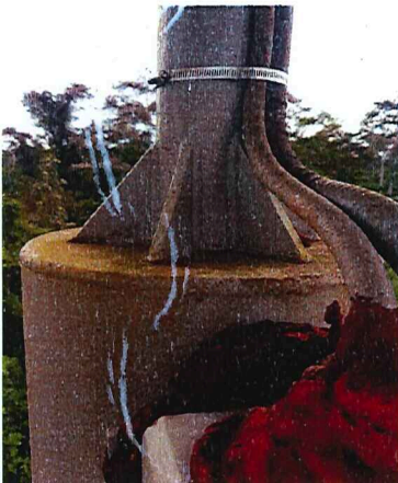
Foto N°32: Unión entre tubo de 16" y 4" soldadas.
