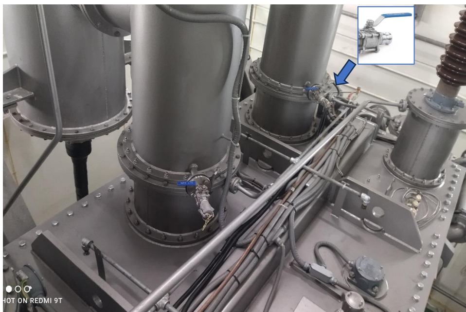
Foto 01 : Vista de muflas (fases U y V) con válvulas de entrada/salida de aceite Ø1" con conector (macho) de acople rápido de Aluminio Tipo C – Camlock
