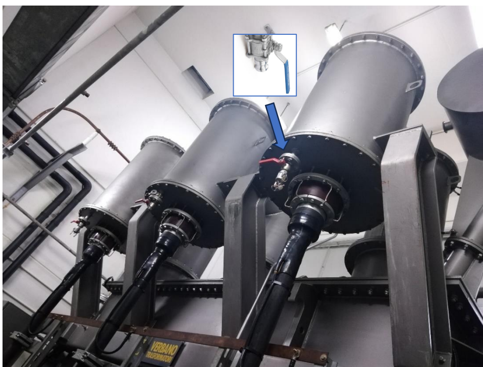
Foto 02 : Vista de muflas (fases U, V y W) lado cables de AT con válvulas de entrada/salida de aceite Ø1" con conector (macho) de acople rápido de Aluminio Tipo C – Camlock
