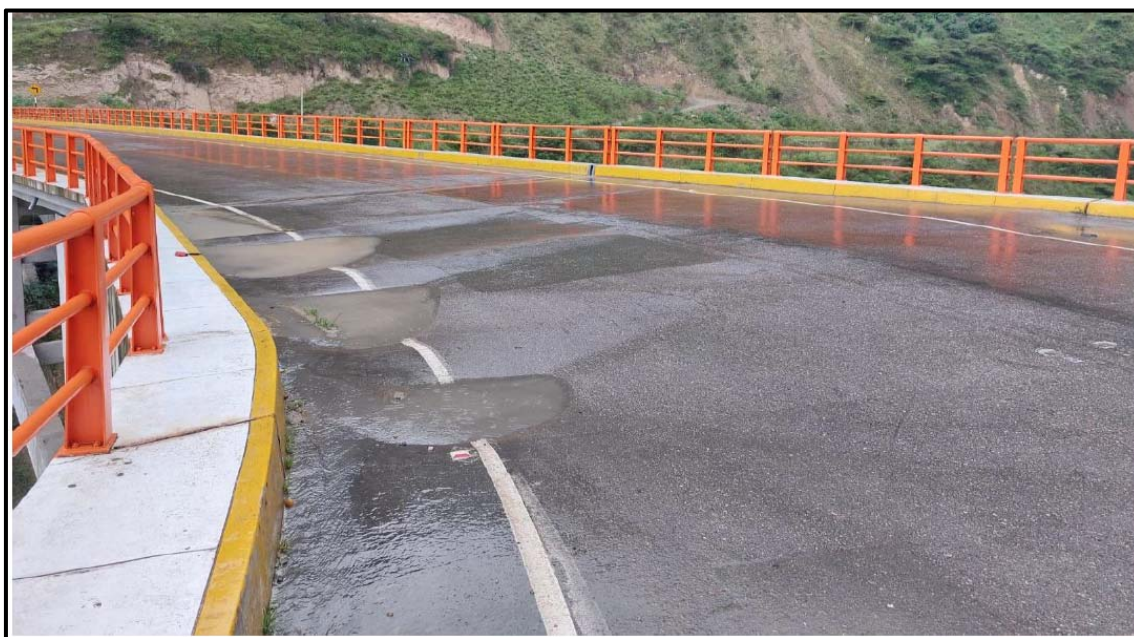
Figura 3. Empozamiento de agua.
