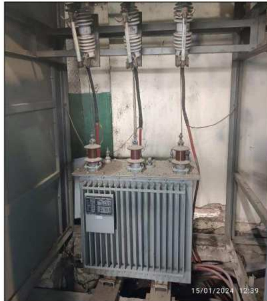
TRANSFORMADOR 10000V A 230V (CONSUMO DE CT)
