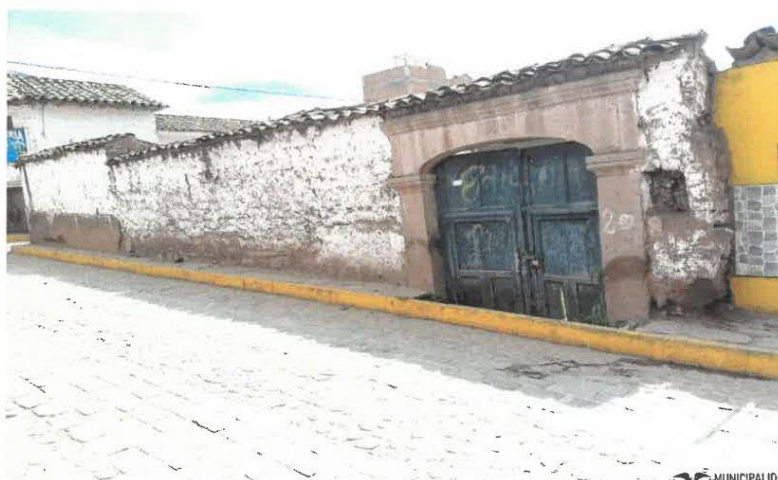
IMAGEN 4 Vista del cerco perimétrico de adobe
