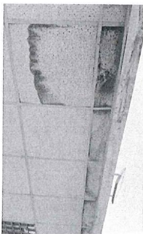
Foto N° 3: Se observa el falso cielo raso de farmacia de emergencia en mal estado.
