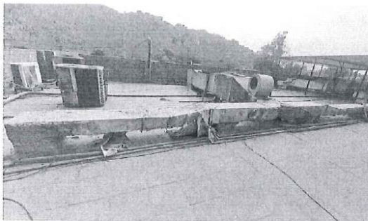
Foto N° 01: Se desmontará los ductos de aire acondicionado en mal estado. Suministro y colocación de nuevo aire acondicionado.
