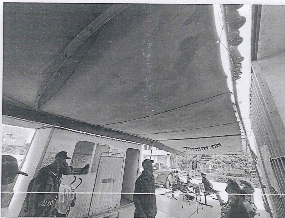
IMAGEN 02: Se observa el material de la cobertura de Sala de Espera, con años de antigüedad y deteriorado - Primer Nivel.
