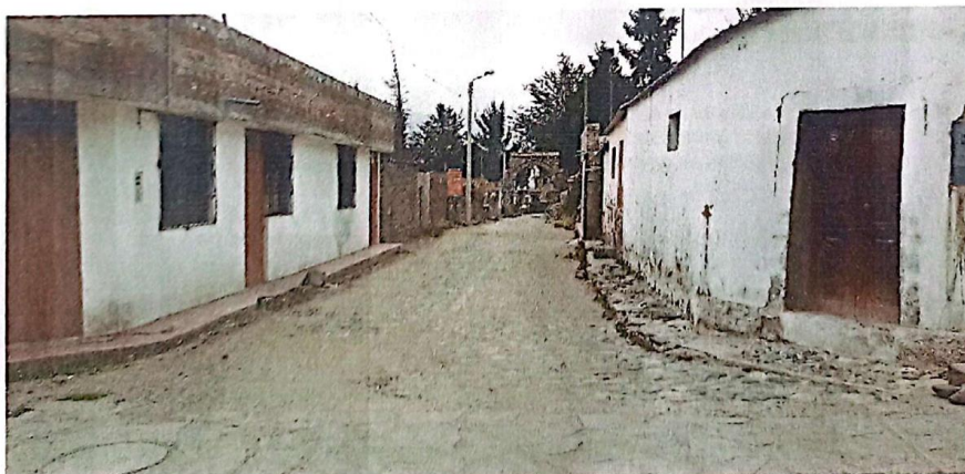
Figura N° 06; Vista de la calle Leticia Cdra 01 que como se aprecia presenta un pavimento rígido en mal estado.
