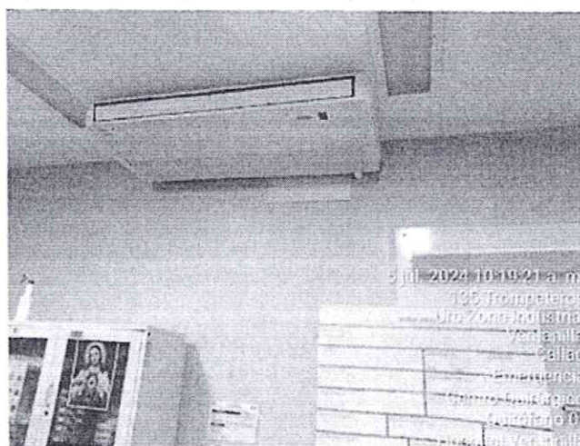
Imagen 04.- Quirófano 1 y 2 con sistema de inyección y extracción inoperativo
