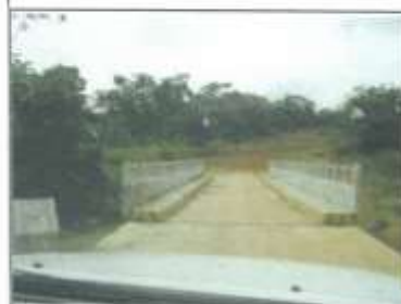
Foto 05: Puente de Concreto, sin servicio. Con Plataforma, Veredas y Barandales en buen estado operativo
