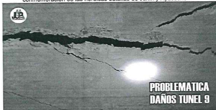
Figura. 1.8-3 Desprendimiento del concreto de la bóveda del Túnel 9
