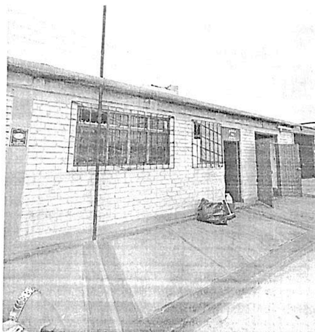
Fachadas de área administrativa desgastada, ventanas antiguas, protectores de metálicos oxidados
