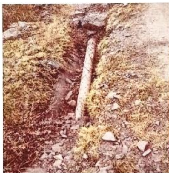
Imagen N° 06 Se puede observar que los beneficiarios colocaron tuberías por diferentes tramos en el canal debido al deterioro
