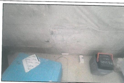
FOTO N.º 08: Los enchufes y cableados de las instalaciones eléctricas del área de cadena de frío, se encuentran expuestos y presentan mala instalación, lo ocasionaría cortos circuitos a las congeladoras.
