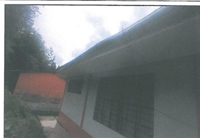
FOTO N.º 15: Las canaletas exteriores se encuentran el mal estado, lo que ocasiona que ocurra filtraciones y deterioro de la pintura ante presencia de lluvias.
