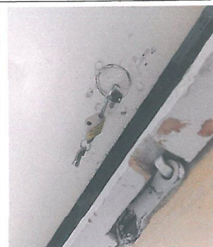
FOTO N°21: reposición de cerrajería por chapa de tres golpes
