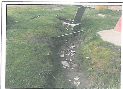
FOTO N.º 19: El drenaje pluvial (no revestido) se encuentra saturado, lo que ocasiona que el buzón y caja de registro colapse.
