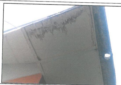
FOTO N.º 04: existe filtración en los cielorrasos, lo que ocasiona el desprendimiento del triple y goteo.
