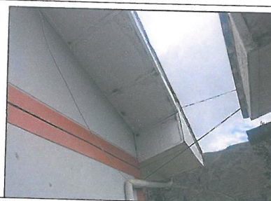
FOTO N.º 05: existe filtración en los cielorrasos, lo que ocasiona el desprendimiento del triple y goteo.
