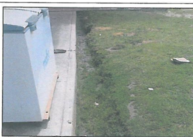
FOTO N.º 16: Las canaletas exteriores se encuentran el mal estado, lo que ocasiona que ocurra filtraciones y deterioro de la pintura ante presencia de lluvias.
