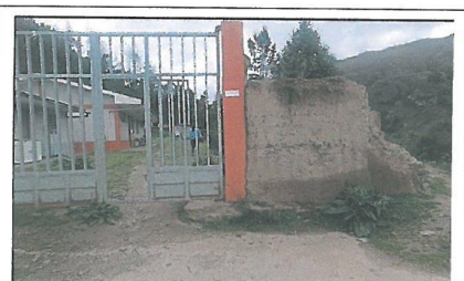
FOTO N.º 23: Cerco perimétrico se está desmoronando, propio del material y saturación de las mismas, se encuentra en mal estado.
