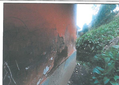
FOTO N.º 21: La pintura exterior del módulo de almacén del Centro de Salud de Carhuapata se encuentra en mal estado.
