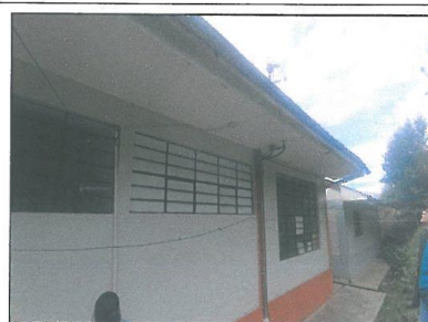
FOTO N.º 16: Las canaletas exteriores se encuentran el mal estado, lo que ocasiona que ocurra filtraciones y deterioro de la pintura ante presencia de lluvias.
