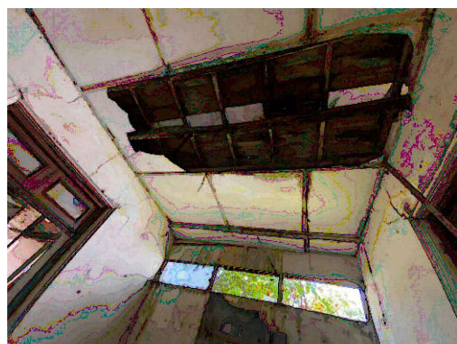
CUBIERTA EN ESTADO DE COLAPSO
