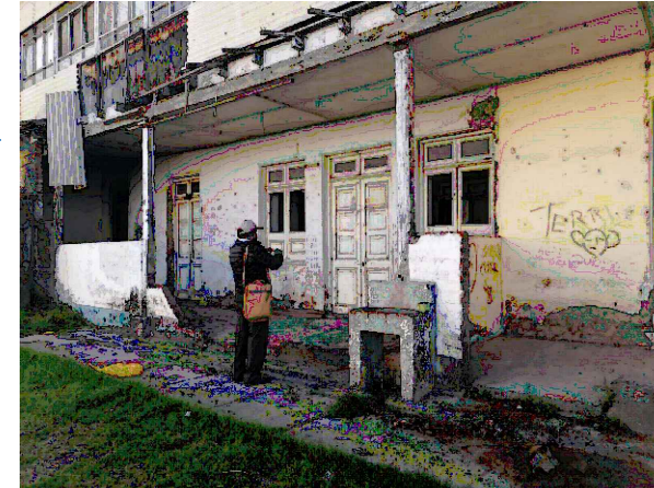
CAÑERIAS INHABILITADAS, VENTANAS SIN VIDRIOS, PUERTA DESGASTADA Y RECUBRIMIENTO DE YESO DESPRENDIDO DE LOS MUROS
