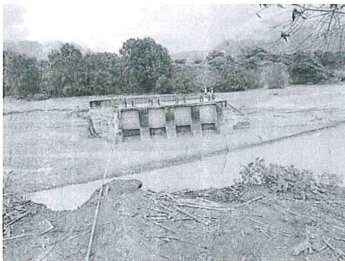
Tramo del río la Leche a la altura de la Bocatoma Magdalena que ha quedado aislado por erosión y rotura del canal Magdalena
