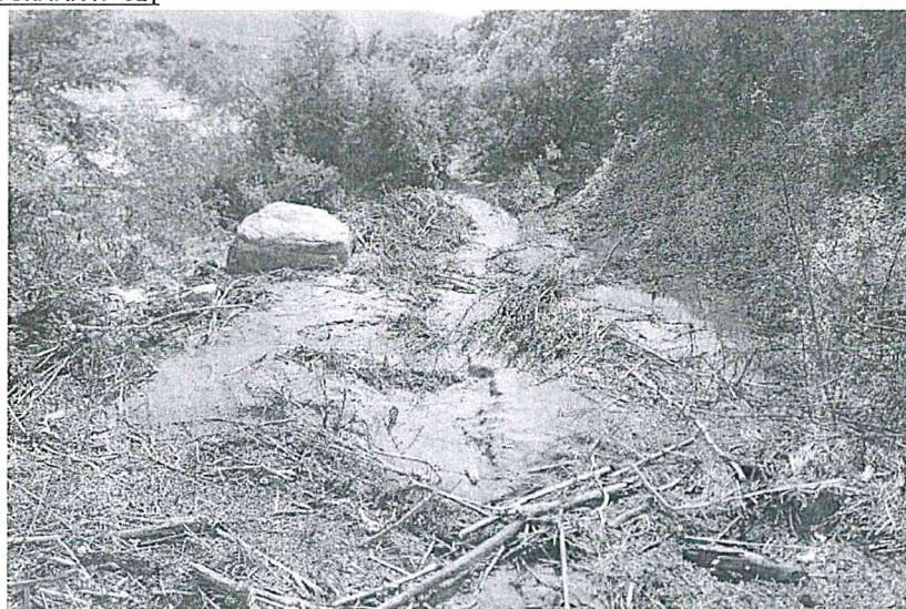
Tramo crítico colmatado del canal El Palmo – Olmos
