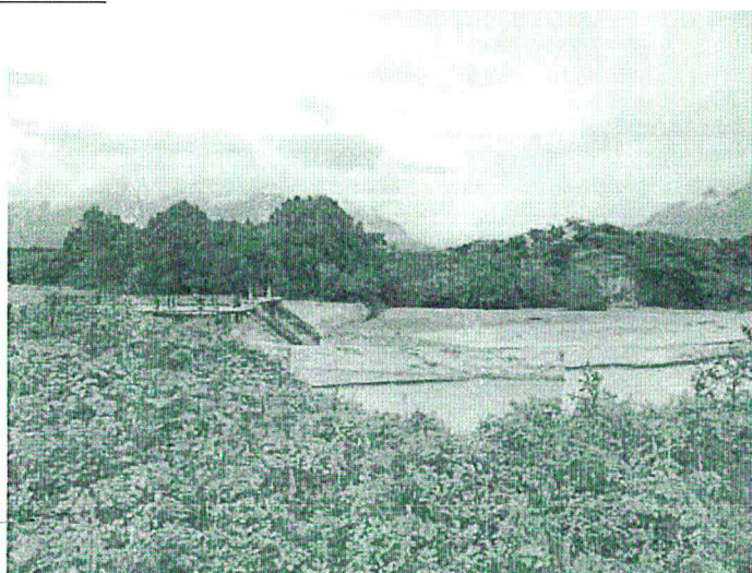
Presencia de sedimentos a la salida del barraje de la Bocatoma Magdalena agua abajo en el rio La Leche
