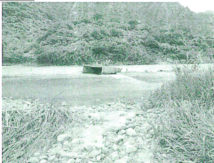
Bocatoma Batangrande colapsado como consecuencia que dique de la margen izquierda del Rio La Leche a erosionado
