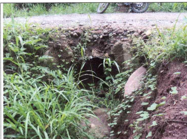
Foto 01: Alcantarilla de concreto ubicado en el km, 0+249, se encuentra en regular estado de conservación.
