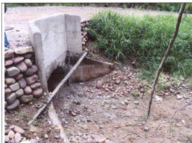
Foto 02: Badén ubicado en el km, 0+341, se encuentra en regular estado de conservación.
