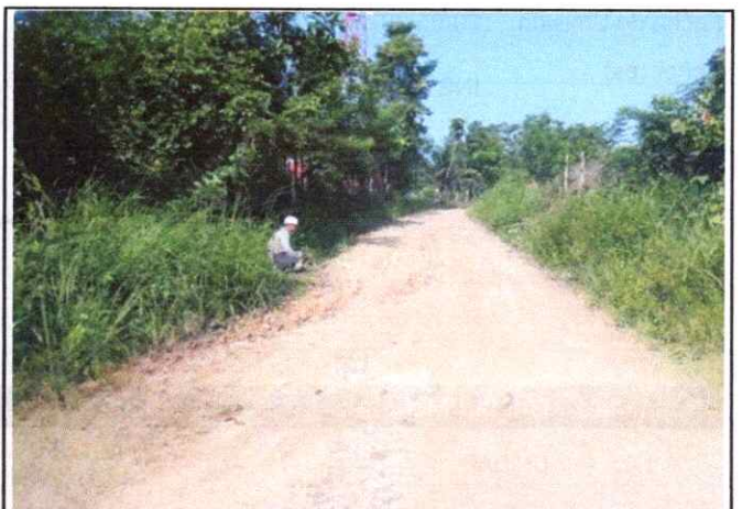
Foto 08: Se observa la topografía del terreno Ondulado con una pendiente de 5% en el Km. 3+750
