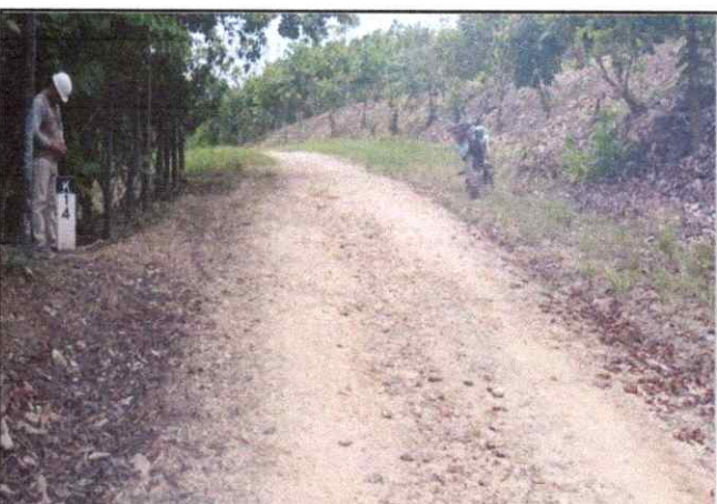
Foto 46: Se observa ahuellamiento erosión de la Plataforma en el Km. 11+250
