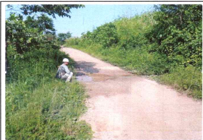
Foto 11: Baden de concreto ubicado en el km 04+805, se encuentra en buen estado de conservación requiere de una limpieza interior.
