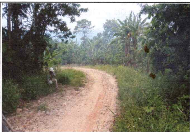
Foto 45: Se observa ahuellamiento, erosión de la Plataforma en el Km. 11+000
