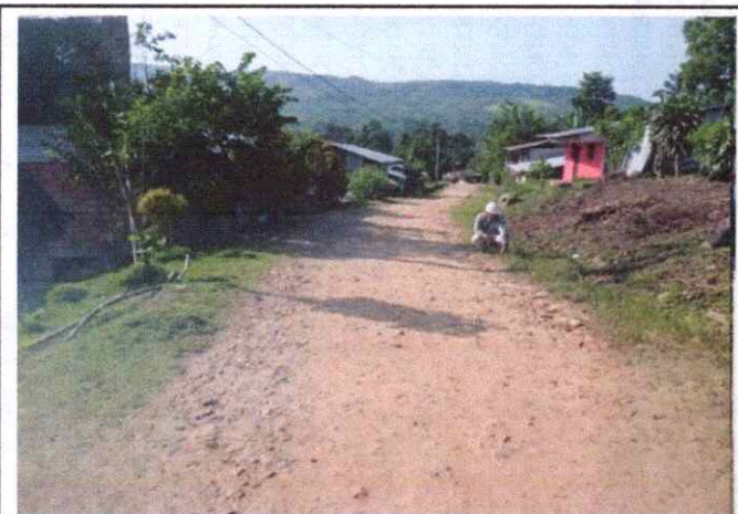
Foto 17: Se observa, ahuellamiento, encalaminado y erosión de la Plataforma en el Km. 4+000
