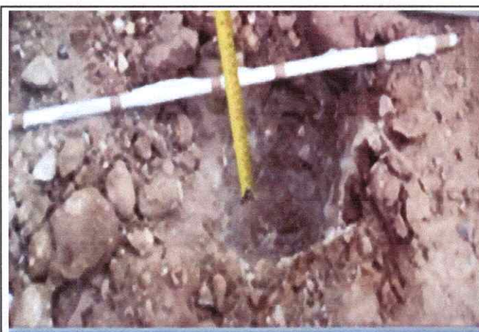
Foto 35: Espesor de la plataforma 0.05 mts. LI En el Km. 8+500
