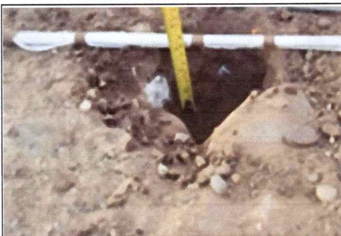
Foto 09: Espesor de la plataforma 0.05 mts. En el Km. 2+000
