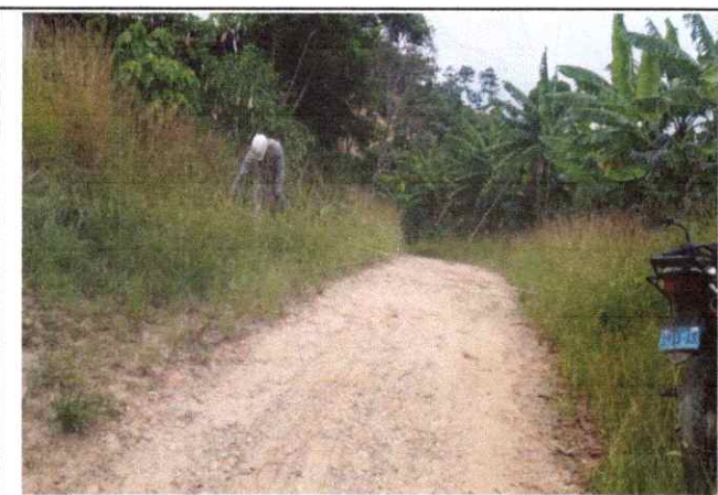
Foto 47: Se observa ahuellamiento, erosión de la Plataforma en el Km. 11+500
