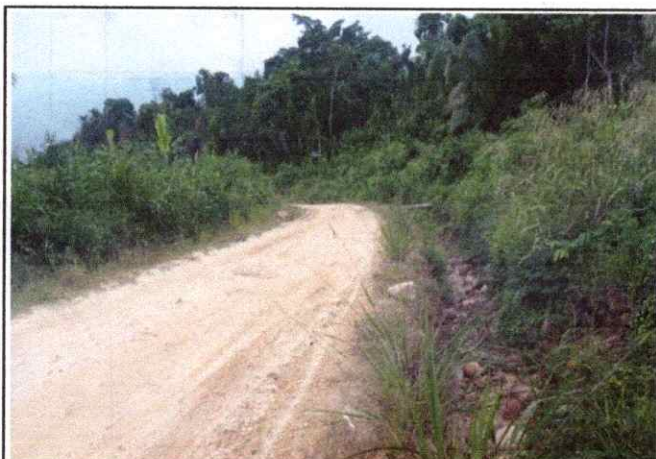
Foto 25: Se observa la topografía del terreno ondulado con una pendiente de 7% en el Km. 10+500
