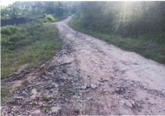
Foto 01: Se observa Baches en la Plataforma en el Km.0+000
