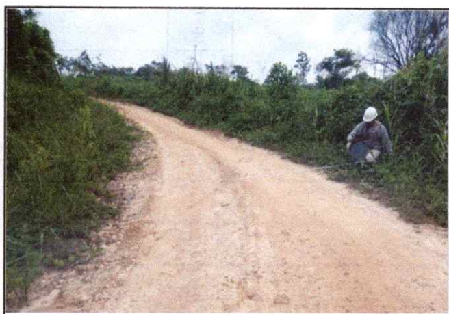
Foto 26: Se observa la topografía del terreno accidentado con una pendiente de 8% en el Km. 10+750
