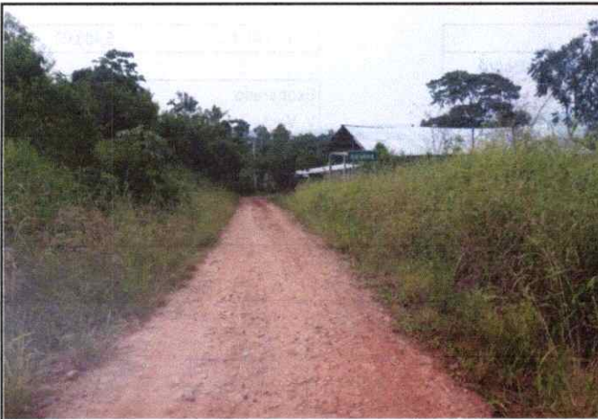
Foto 33: Se observa erosión de la Plataforma en el Km. 8+000
