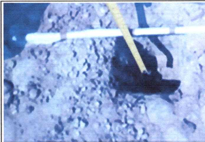
Foto 26: Espesor de la plataforma 0.05 mts. LD En el Km. 6+250
