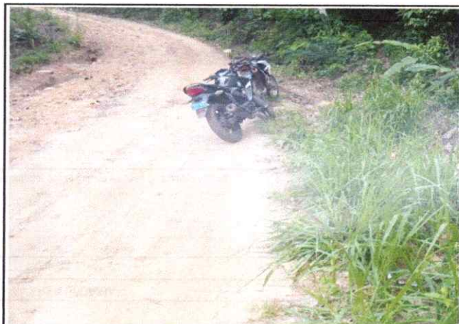
Foto 38: Se observa erosión de la Plataforma en el Km. 9+250
