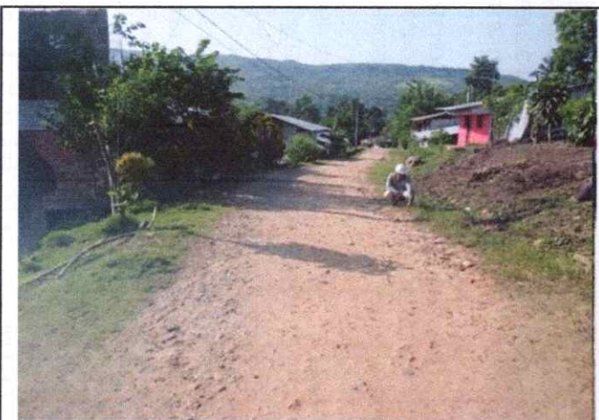
Foto 15: Se observa erosión de la Plataforma en el Km. 3+500
