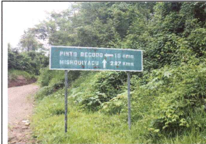
Foto 01: Señal Informativa 00+0170 , Se observa señal en mal estado
