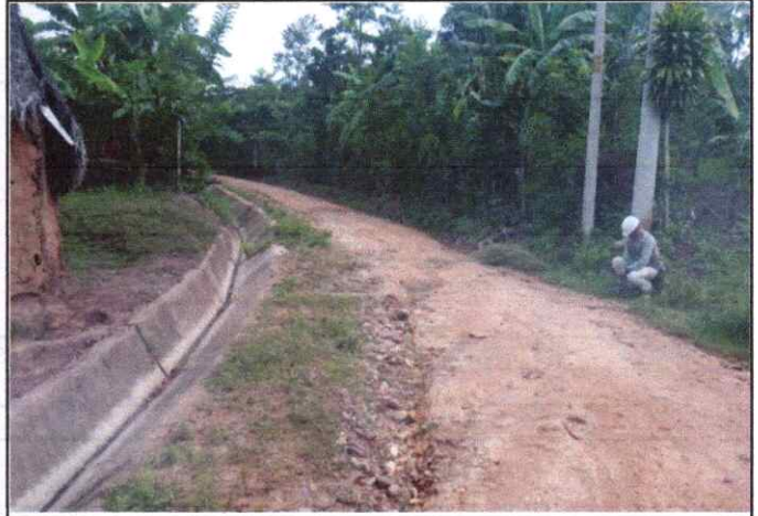
Foto 32: Se observa ahuellamiento erosión de la Plataforma en el Km. 7+750
