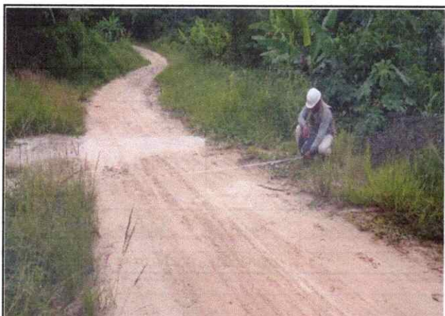
Foto 39: Se observa erosión de la Plataforma en el Km. 9+500
