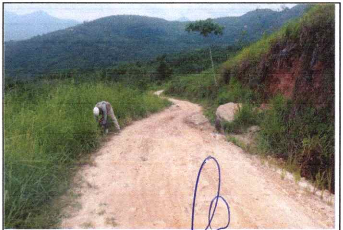
Foto 36: Se observa ahuellamiento y erosión de la Plataforma en el Km. 8+750
