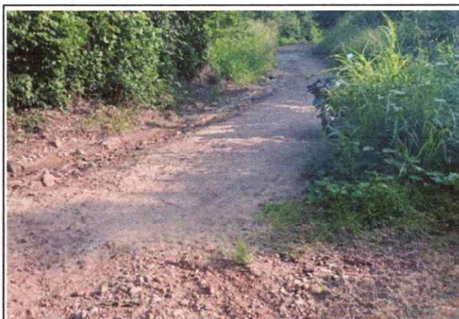
Foto 08: observa encalaminado y ahuellamiento en la Plataforma Km. 1+750
