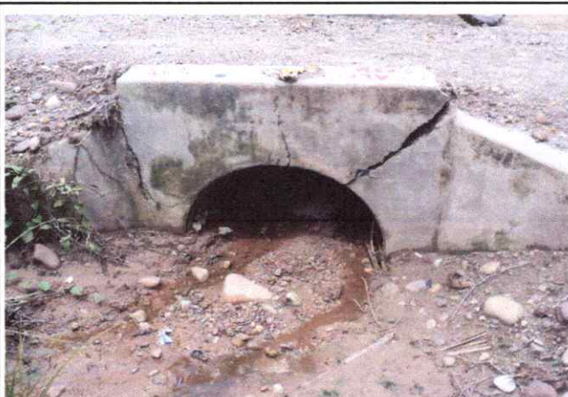
Foto 04: Alcantarilla ubicado en el km, 01+350, se encuentra en regular estado de conservación.
