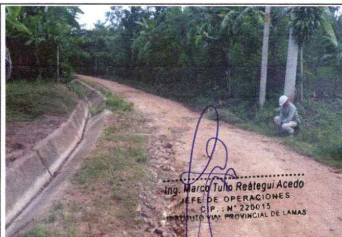
Foto 18: Se observa la topografía del terreno Accidentado con una pendiente de 8% en el Km. 8+500
