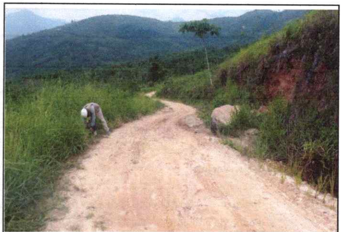
Foto 20: Se observa la topografía del terreno ondulado con una pendiente de 6% en el Km. 9+250
