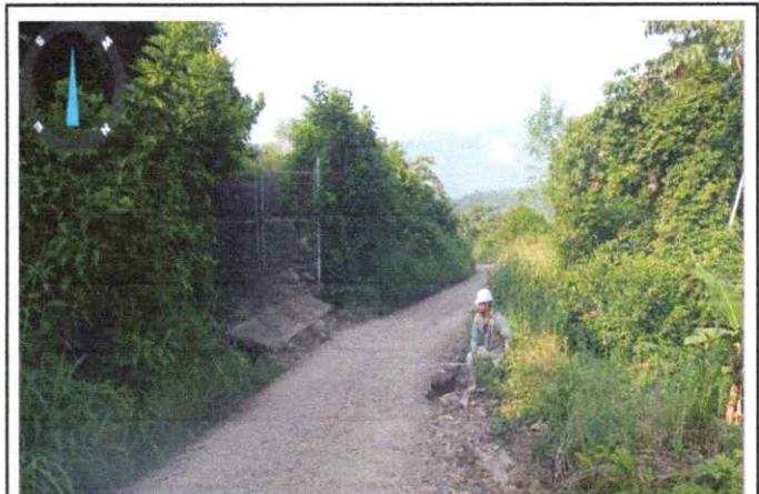
Foto 04: Se observa encalaminado y erosion de la Plataforma en el Km. 0+750
