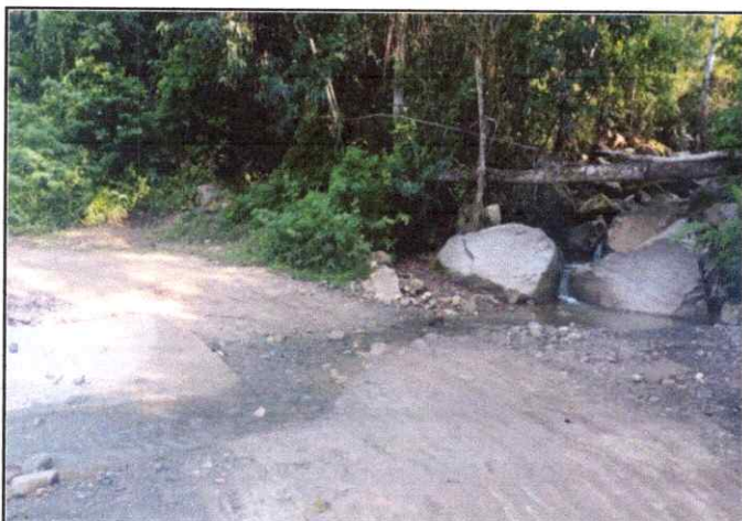
Foto 13: Se observa la topografía del terreno Accidentado con una pendiente de 7% en el Km. 6+050
