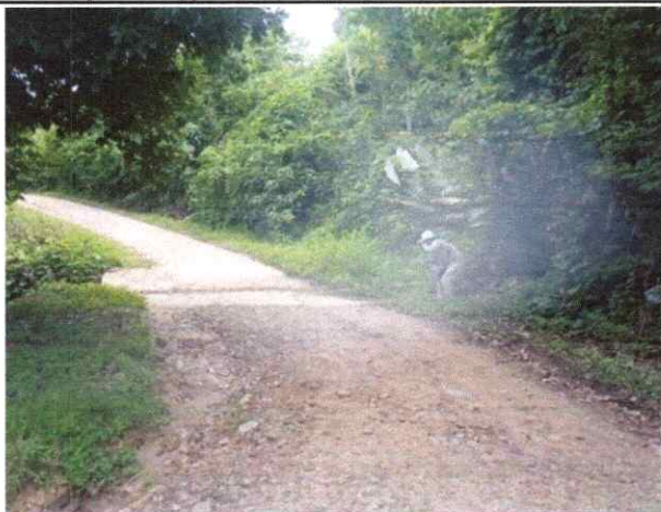
Foto 19: Badén de concreto ubicado en el km 10+233, se encuentra en regular estado de conservación.
