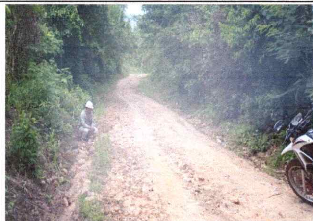
Foto 51: Se observa erosión de la Plataforma en el Km. 12+500
