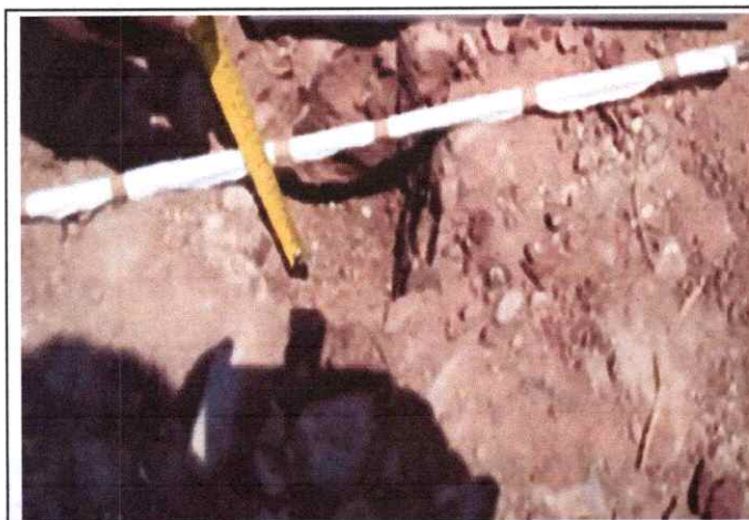
Foto 53: Espesor de la plataforma 0.04 mts. LD En el Km. 13+000
