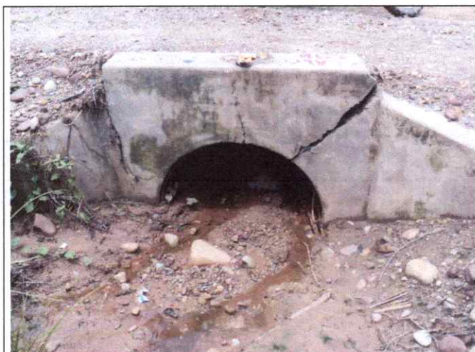
Foto 04: Alcantarilla ubicado en el km, 01+350, se encuentra en regular estado de conservación.
