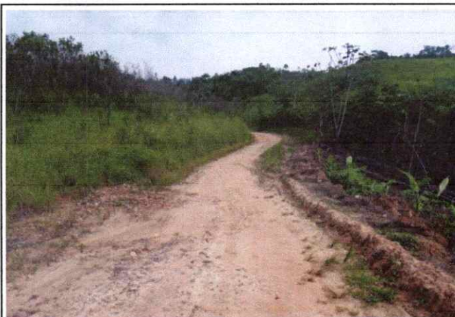
Foto 35: Se observa ahuellamiento y erosión de la Plataforma en el Km.8+500
