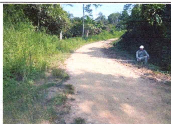
Foto 20: Se observa erosión de la Plataforma en el Km. 4+750
