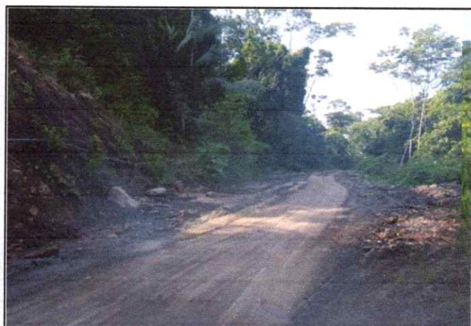
Foto 26: Se observa ahuellamiento y erosión de la Plataforma en el Km. 6+250
