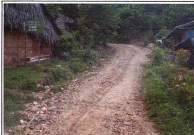
Foto 52: Se observa erosión de la Plataforma en el Km. 12+750
