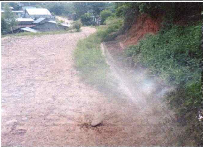
Foto 31: Se observa ahuellamiento, erosión de la Plataforma en el Km.7+500
