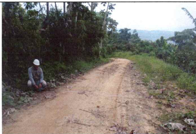
Foto 23: Se observa la topografía del terreno ondulado con una pendiente de 9% en el Km. 10+000
