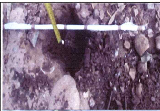
Foto 34: Espesor de la plataforma 0.05mts. EJE En el Km. 8+250
