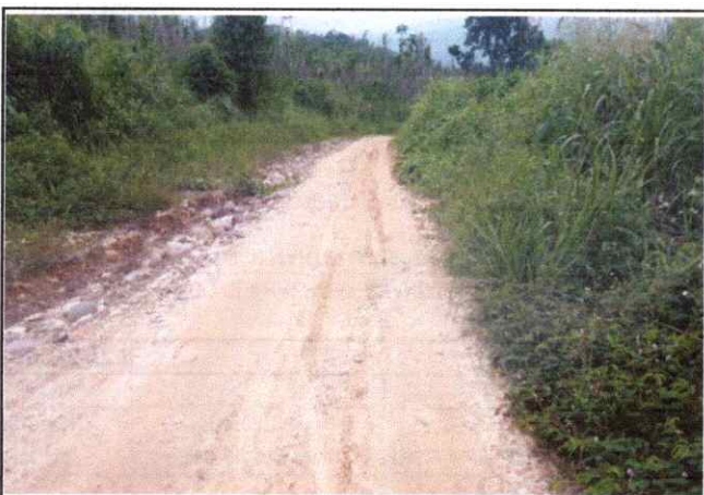
Foto 41: Se observa erosión de la Plataforma en el Km. 10+000
