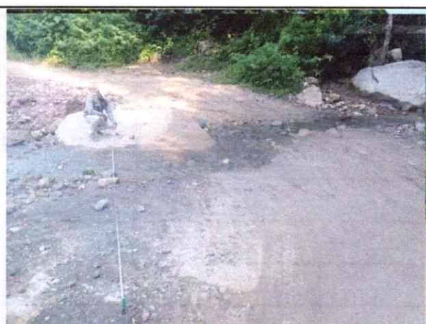
Foto 10: Badén ubicado en el km 04+550, se encuentra en mal estado de conservación.
