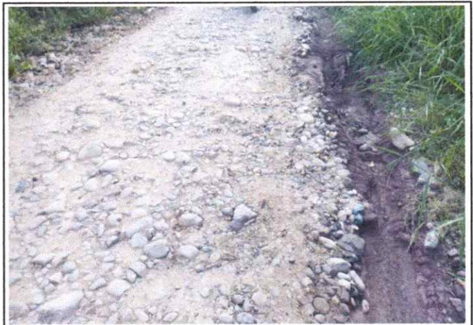
Foto 02: Se observa encalaminado en la Plataforma en el Km. 0+250
