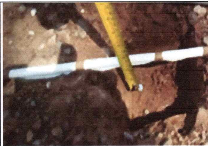
Foto 50: Espesor de la plataforma 0.04 mts. LD En el Km. 12+250
