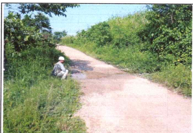
Foto 28: Se observa erosión, ahuellamiento de la Plataforma en el Km. 6+750
