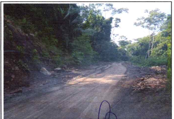
Foto 12: Se observa la topografía del terreno ondulado con una pendiente de 4% en el Km. 5+550
