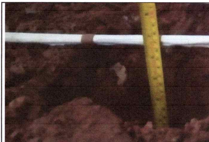
Foto 16: Espesor de la plataforma 0.04 mts. En el Km. 3+750
