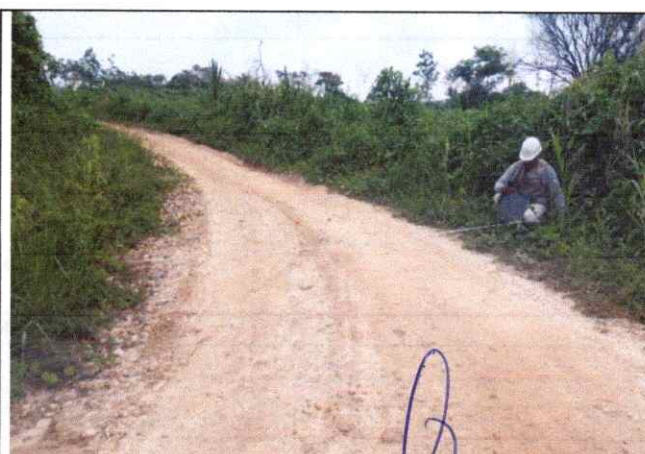
Foto 42: Se observa ahuellamiento, erosión de la Plataforma en el Km. 10+250
