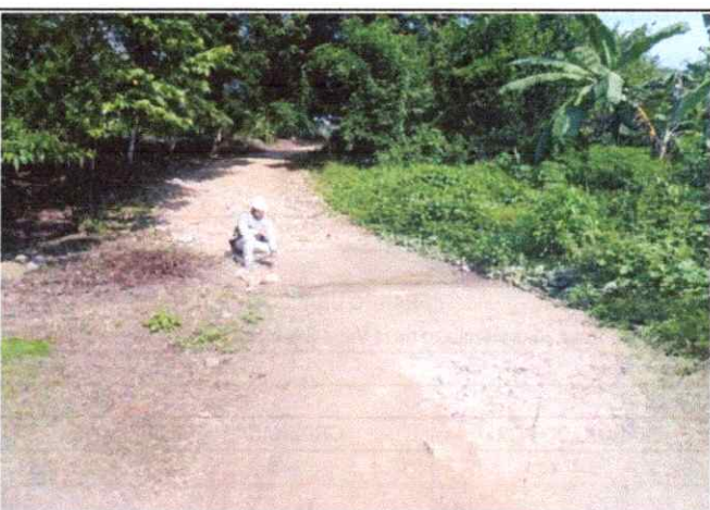
Foto 22: Se observa erosión de la Plataforma en el Km. 5+250
