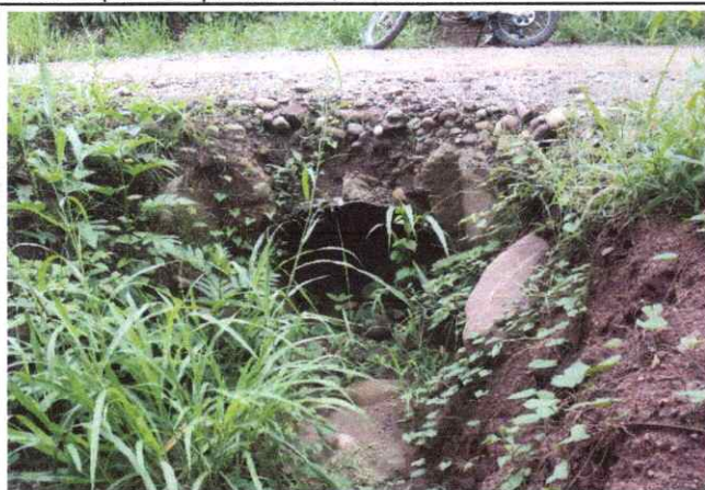
Foto 01: Alcantarilla de concreto ubicado en el km, 0+249, se encuentra en regular estado de conservación.
