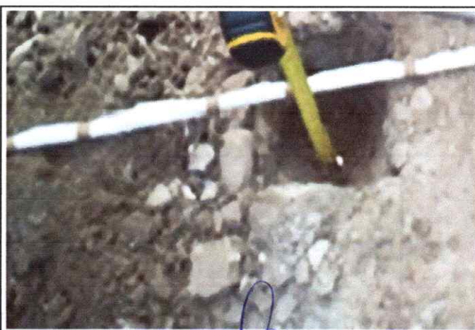
Foto 36: Espesor de la plataforma 0.05 mts. LD En el Km. 8+750
