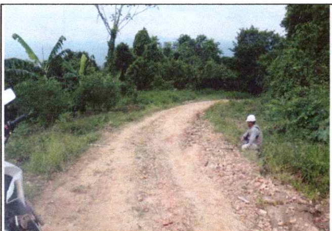
Foto 29: Se observa la topografía del terreno ondulado con una pendiente de 8% en el Km. 11+500
