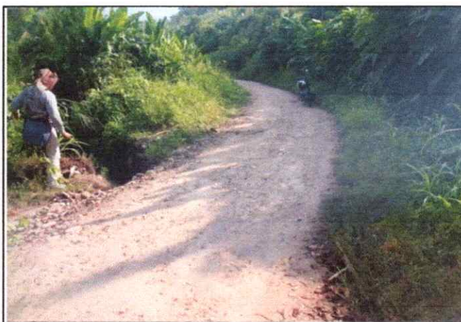
Foto 10: Se observa encalaminado de la Plataforma en el Km. 2+250
