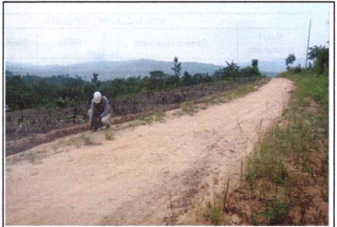
Foto 34: Se observa ahuellamiento y erosión de la Plataforma en el Km. 8+250
