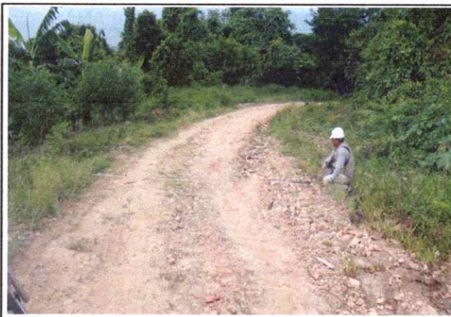
Foto 44: Se observa ahuellamiento, erosión de la Plataforma en el Km. 10+750
