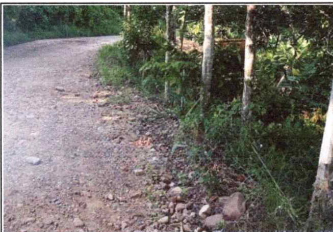
Foto 03: Se observa la topografía del terreno Ondulado con una pendiente de 4% en el Km. 1+000
