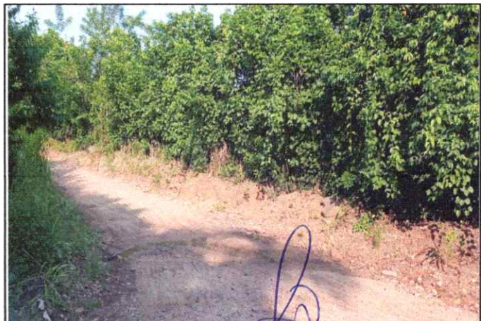
Foto 06: Se observa Ahusamiento de la Plataforma en el Km.1+250
