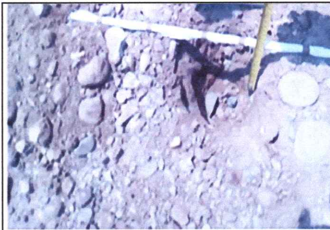
Foto 28: Espesor de la plataforma 0.06 mts. EJE En el Km. 6+750
