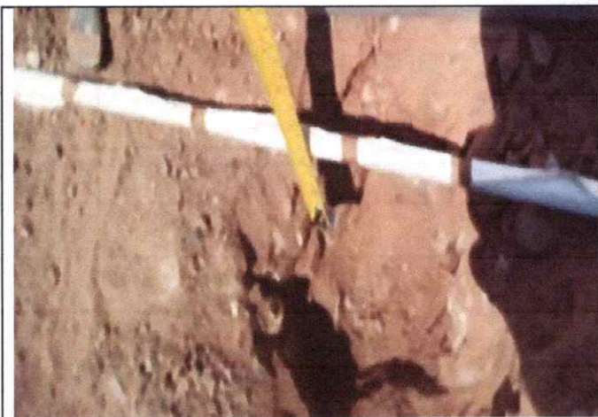
Foto 49: Espesor de la plataforma 0.05 mts. LI En el Km. 12+000
