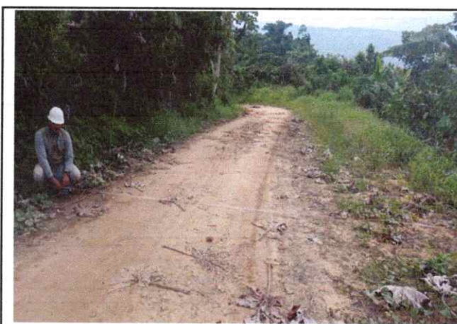
Foto 40: Se observa ahuellamiento, erosión de la Plataforma en el Km. 9+750
