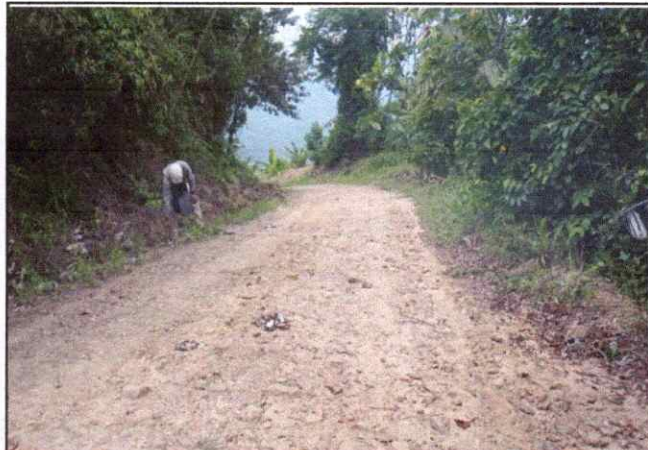
Foto 50: Se observa erosión de la Plataforma en el Km. 12+250
