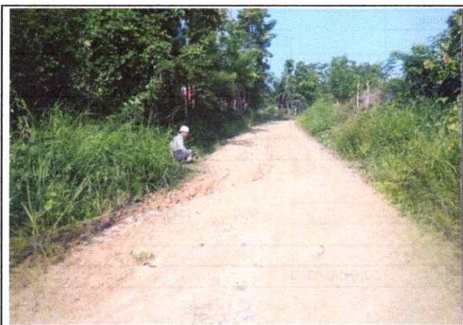
Foto 21: Se observa erosión de la Plataforma en el Km. 5+000
