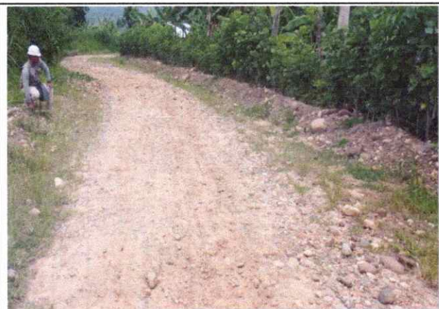
Foto 53: Se observa erosión de la Plataforma en el Km. 13+000
