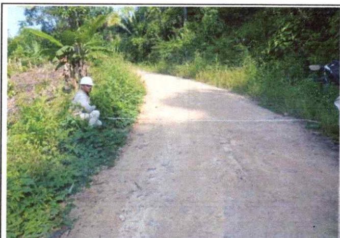
Foto 27: Se observa erosión de la Plataforma en el Km. 6+500
