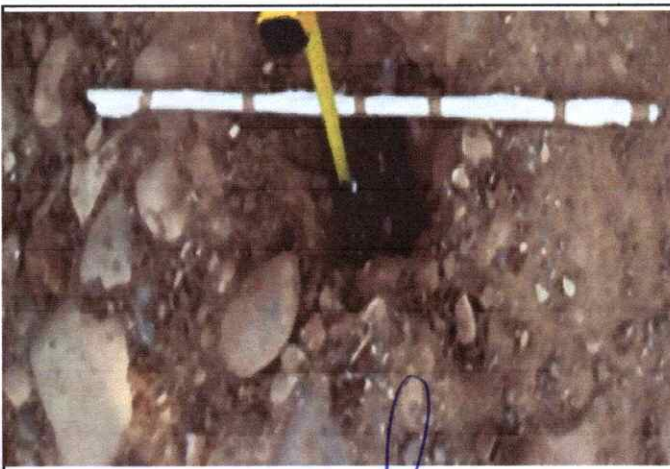
Foto 54: Espesor de la plataforma 0.04 mts. EJE En el Km. 13+250
