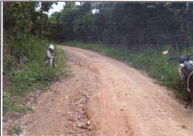
Foto 43: Se observa ahuellamiento, erosión de la Plataforma en el Km. 10+500
