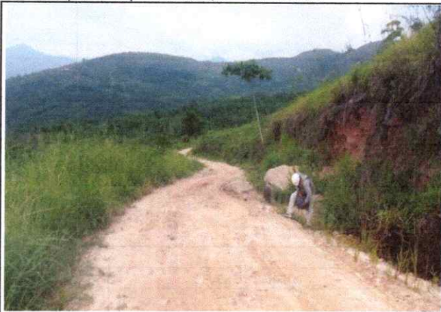
Foto 37: Se observa erosión de la Plataforma en el Km. 9+000
