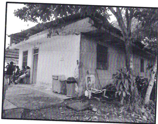
FOTO 03 – (28-02-2023) Se observa en la imagen el cielorraso de concreto del bloque 01 el cual esta en mal estado por las filtraciones que tiene la cobertura en mal estado.
