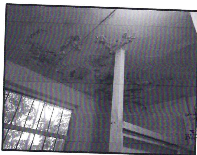
FOTO 04 – (28-02-2023) Se observa en la imagen el deterioro del cielorraso por filtraciones de la cobertura en mal estado.
