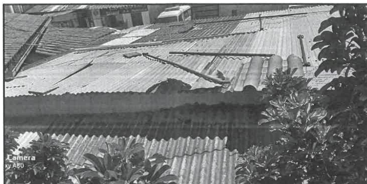
IMAGEN 2: Cobertura deteriorada del área de Servicios Generales
