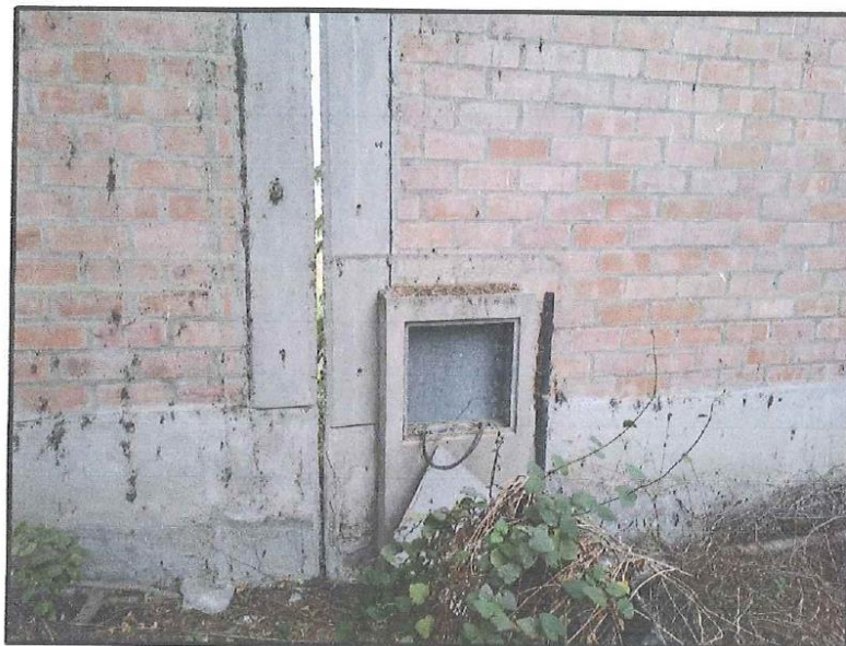
Juntas de construcción, sin sello elastómerico
