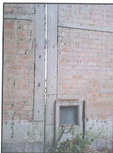
Juntas de dilatación de 1" a lo largo de toda su altura.
