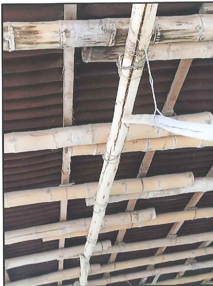
Imagen N°07: Estructura de madera soportada con alambre galvanizado y guayaquil y correas de madera de 2"x2".
