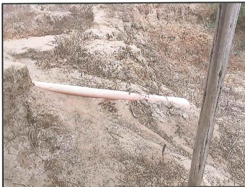
Imagen N° 21: Protección de tuberías de drenaje de tubería PVC de diámetro 8"
