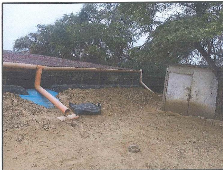
Imagen N° 01: Sacos de polietileno, a ser protegidos por material de relleno compactado.
