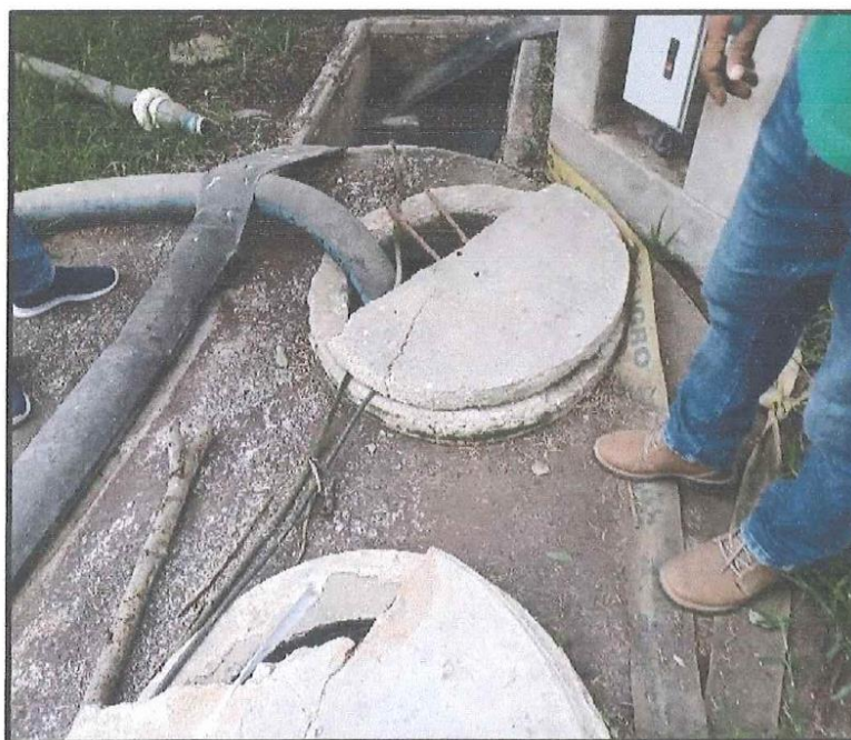
Reposición de tapas de concreto en pozos sépticos (02 und circulares y 01 tapa rectangular)
