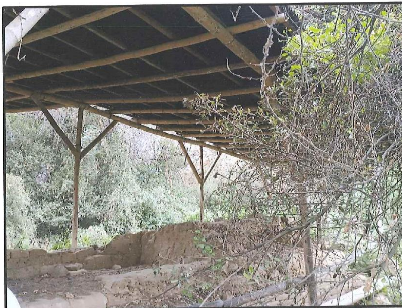
Imagen N° 08: Cobertura de fibra vegetal, con estructura de Eucalipto, el mismo que necesita una limpieza y desbroce de maleza y el cambio de cobertura y estructura de madera.
