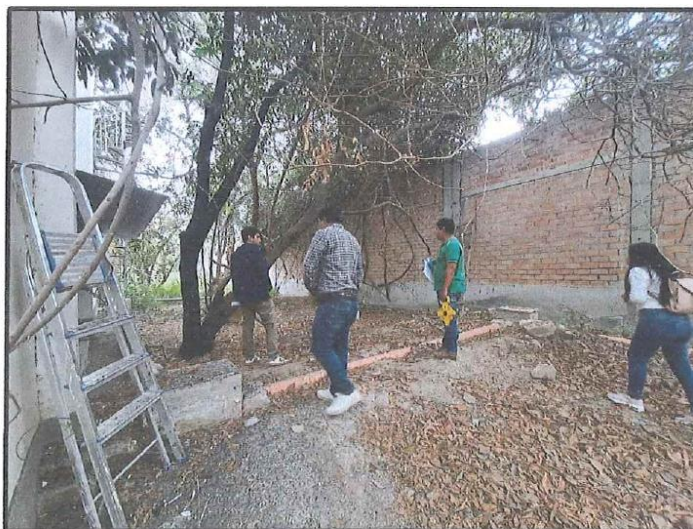
Tubería expuesta de los desagües, los mismos que deben ser rellenado con material de préstamo en forma de pirámide trunca.
