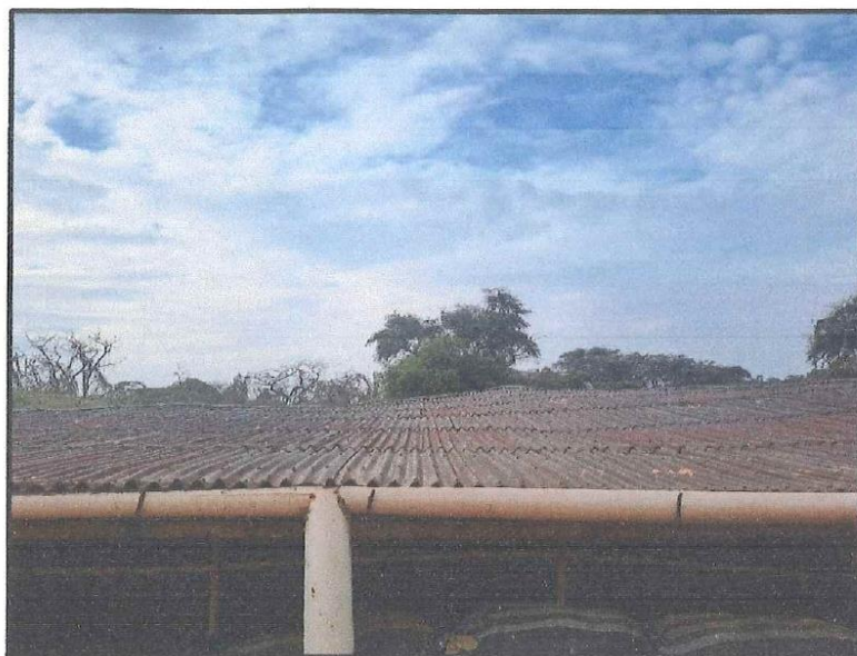
Imagen N° 07: cobertura deformada y con goteras, producto de la deformación de la estructura inicial.
