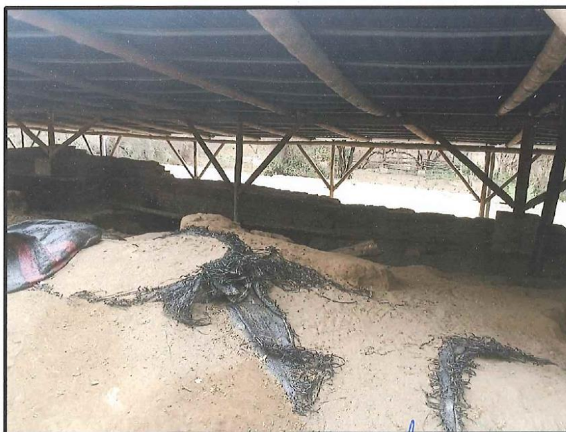
Imagen N° 27: Cambio de sacos de tierra y/o arena para protección de escorrentías de agua.
