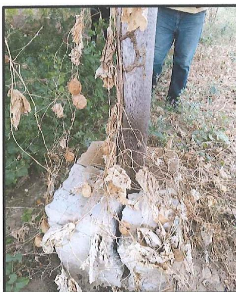
Imagen N° 04: Postes deteriorados por la plinia, invadidos por conejen y dados de concreto sin refuerzo de acero.
