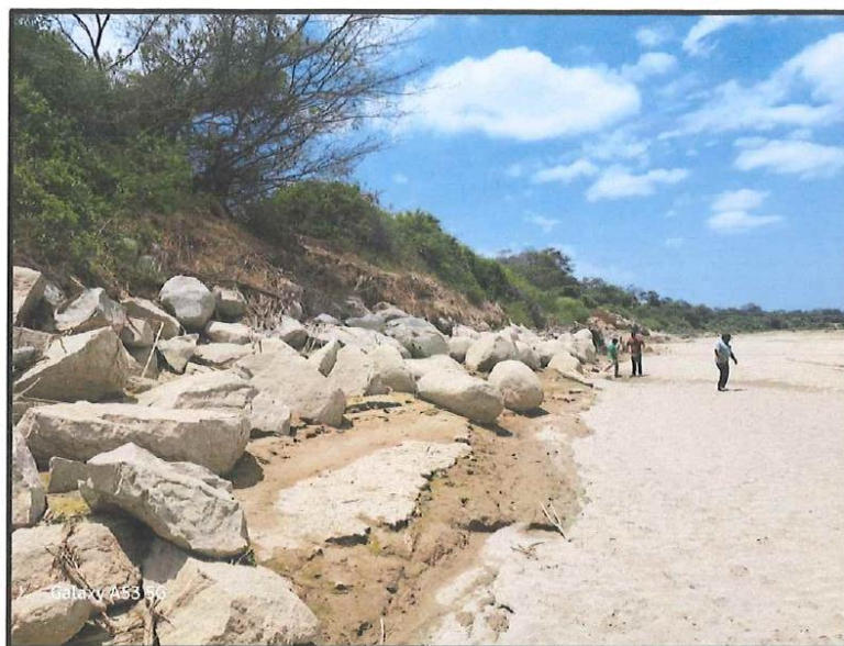
Imagen N° 03: Para la colocación de sacos terreros, se debe hacer un trabajo previo de retiro de las rocas existentes, para luego acomodarlos como protección de la base en donde se colocarán los sacos.
