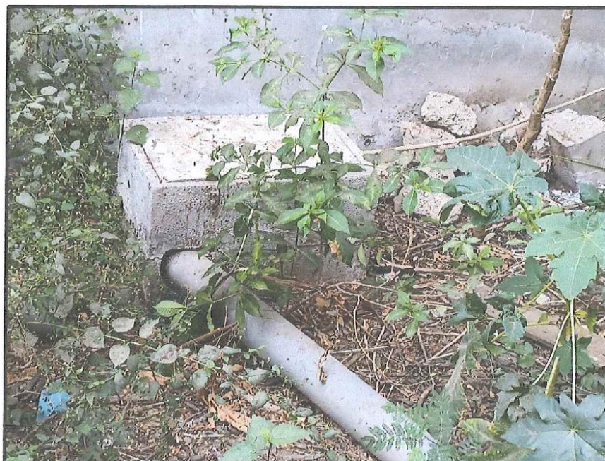
Cajas de desagüe sin tarrajeo exterior y presencia de fuga de aguas hervidas.
