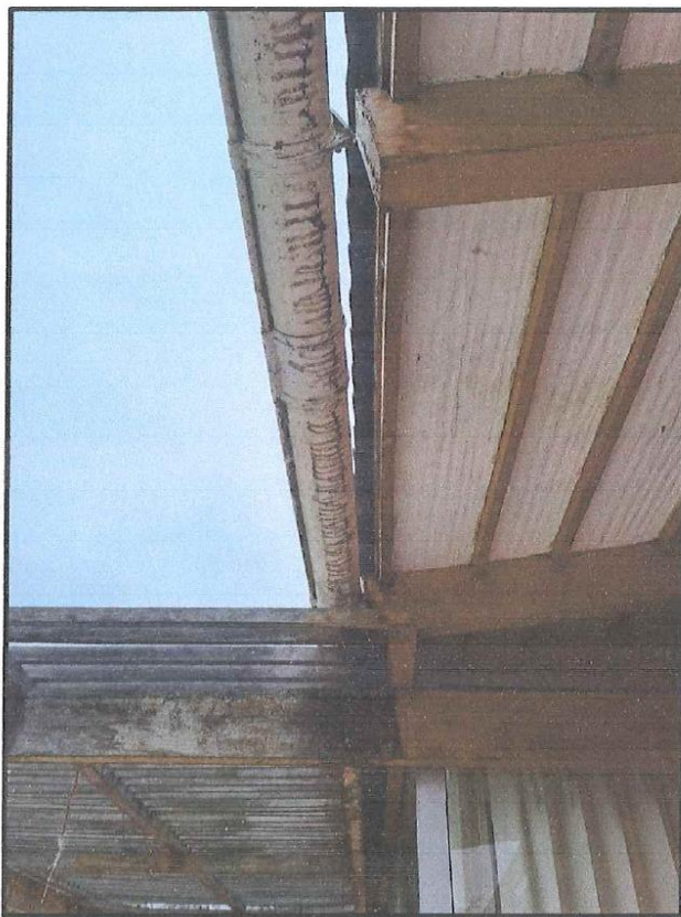
Mejoramiento (alineación y fijación de canaleta de PVC de 125mm), en una longitud de 8.50ml
