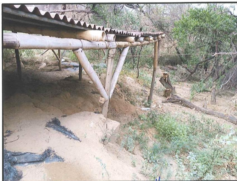
Imagen N° 25: Estructura de soportes de Eucalipto y correas de guataquil, sin mantenimiento.
