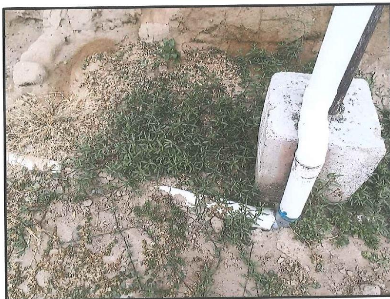
Imagen N° 18: Renovación de las tubería de descarga de aguas pluviales (bajada de montantes).
