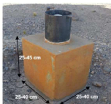
Figura 4: Modelo referencial de dado de concreto
