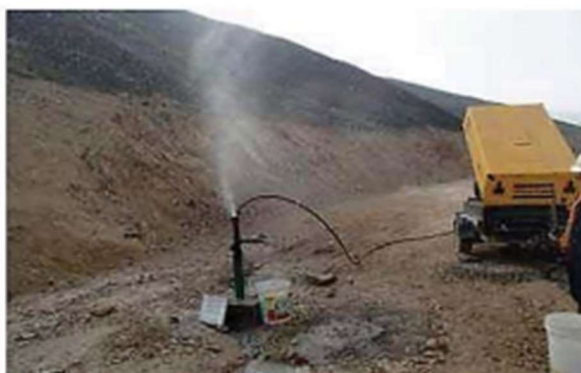
Figura 1: Expulsión de agua con aire comprimido
