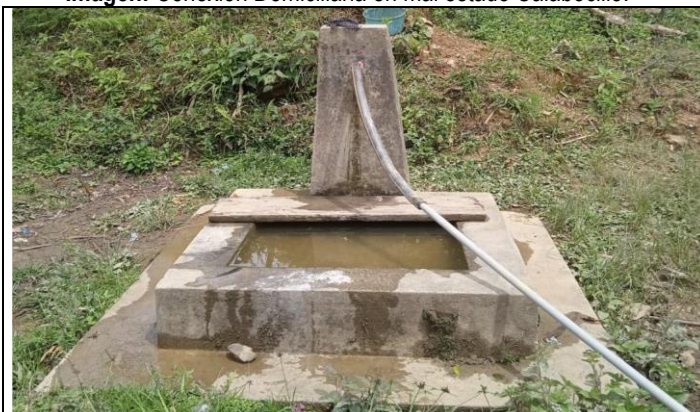
Imagen: Conexión Domiciliaria en mal estado Calabocillo.
