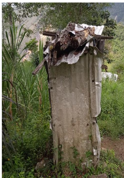
Imagen: Estado situacional Pozos de Hoyo seco ventilado.
