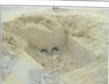
Foto 04: Ingreso de alcantarilla de desfogue en inicio de tramo, dos tuberías 8" cada una. Cabezal de ingreso en malas condiciones y obstruido.
