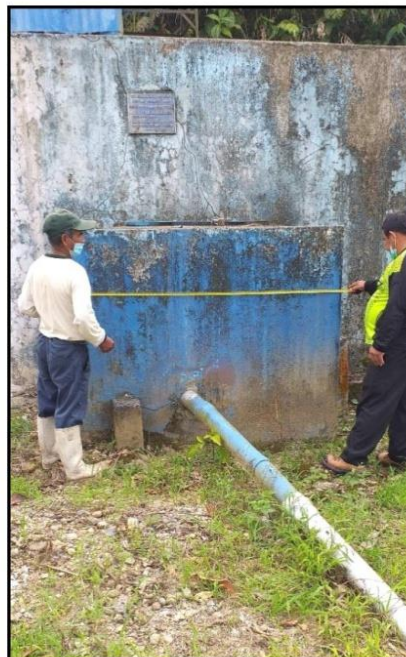
Imagen: Línea de aducción expuesta (Reservorio 1).
