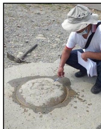
Imagen: Tapa de buzón sellado, no se puede destapar. (Sector San Isidro)
