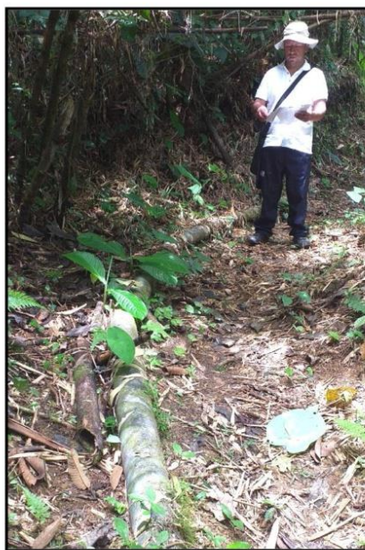
Imagen: Línea de aducción expuesto (Reservorio 3)
