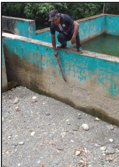
Imagen: Material de filtro sin mantenimiento y Revestimiento interior deteriorado.
