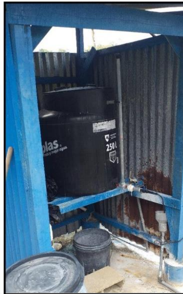
Imagen: Sistema de Cloración artesanal (Reservorio 1)
