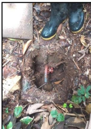
Imagen: Válvula de aire en Línea de Conducción.
