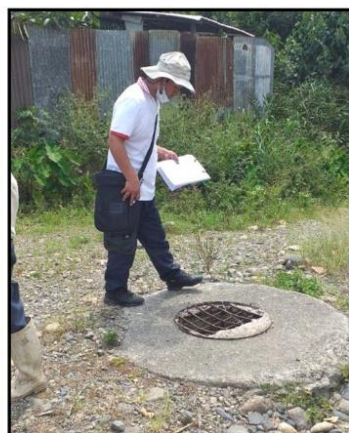
Imagen: Tapa de buzón en mal estado. (Sector San Isidro)
