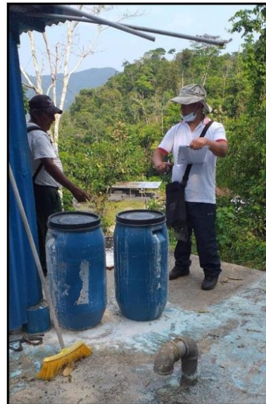
Imagen: Sistema de Cloración artesanal (Reservorio 1)
