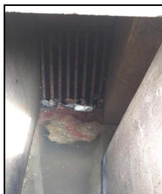
Imagen: Interior de Cámara de rejillas, sin mantenimiento. (Sector San Isidro)
