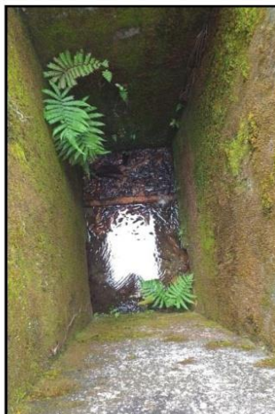
Imagen: Compartimiento de limpieza sin mantenimiento
