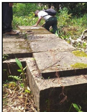
Imagen: Cámara de rejillas en estado de abandono. (Sector San Isidro)
