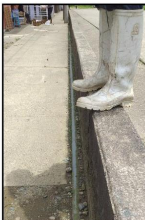
Imagen: Tubería de agua expuesta.
