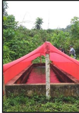
Imagen: Sedimentador de concreto armado.
