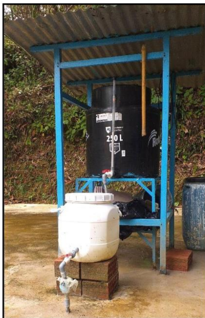
Imagen: Sistema de Cloración Artesanal (Reservorio 3)
