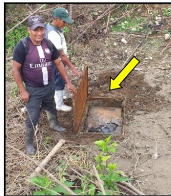
Imagen: Tanque séptico colmatado de lodo. (todos los tanques sépticos se encuentran en esta situación)
